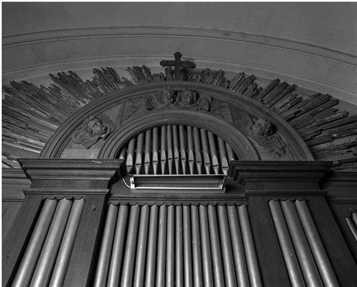
Couronnement vu en contre-plongée.
