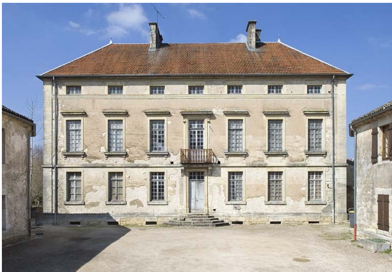
Logement patronal (31 rue Carnot). Façade antérieure.
