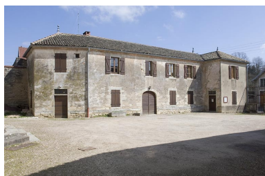
Logement patronal (31 rue Carnot). Dépendance nord. Phot. Jérôme Mongreville IVR43_20097000297NUC2A
