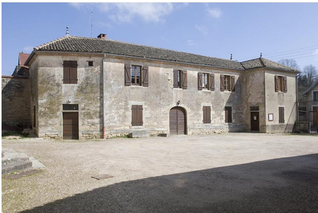
Logement patronal (31 rue Carnot). Dépendance nord.
