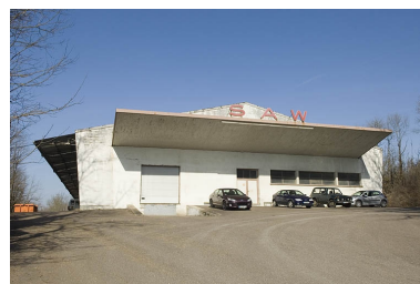
Mur-pignon de l'atelier de fabrication (rondelles). Phot. Jérôme Mongreville IVR43_20097000158NUC2A
