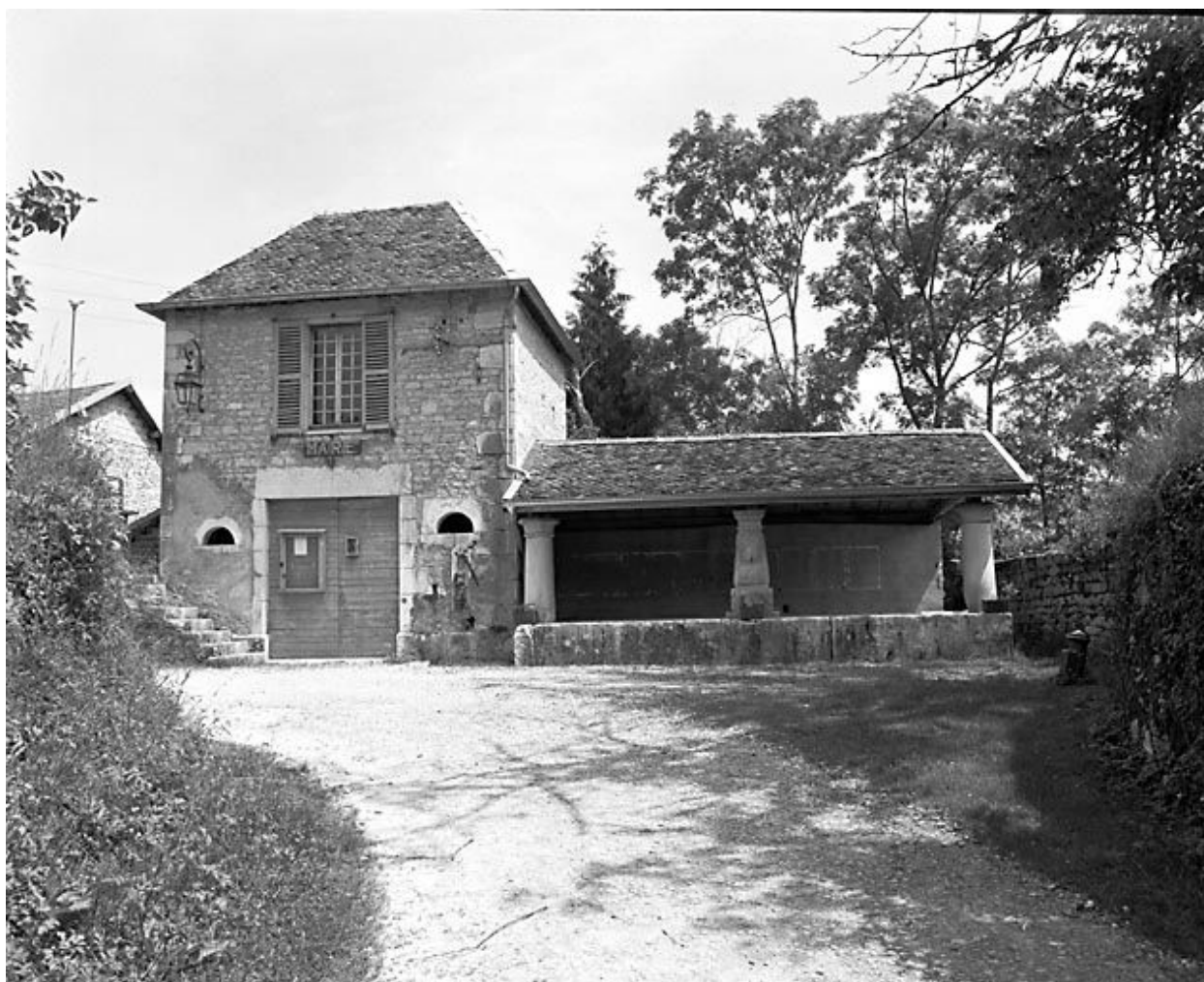
Fontaine-lavoir située rue des Vignerons.
