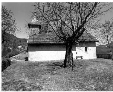
Façade sud. Phot. Jérôme Mongreville IVR43_19973900227X
