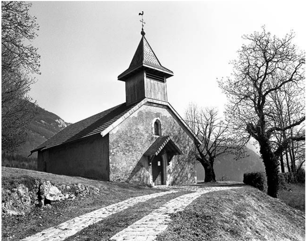
La chapelle : façade ouest.
