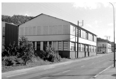
Magasin industriel (ancien atelier de fabrication). Phot. Laurent Poupard IVR43_19913901302Z
