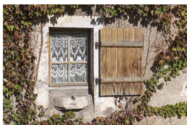
Façade sur la rue des Glacis, détail : la sortie d'évier (ou goulotte). Phot. Jérôme Mongreville IVR43_20127000499NUC4A
