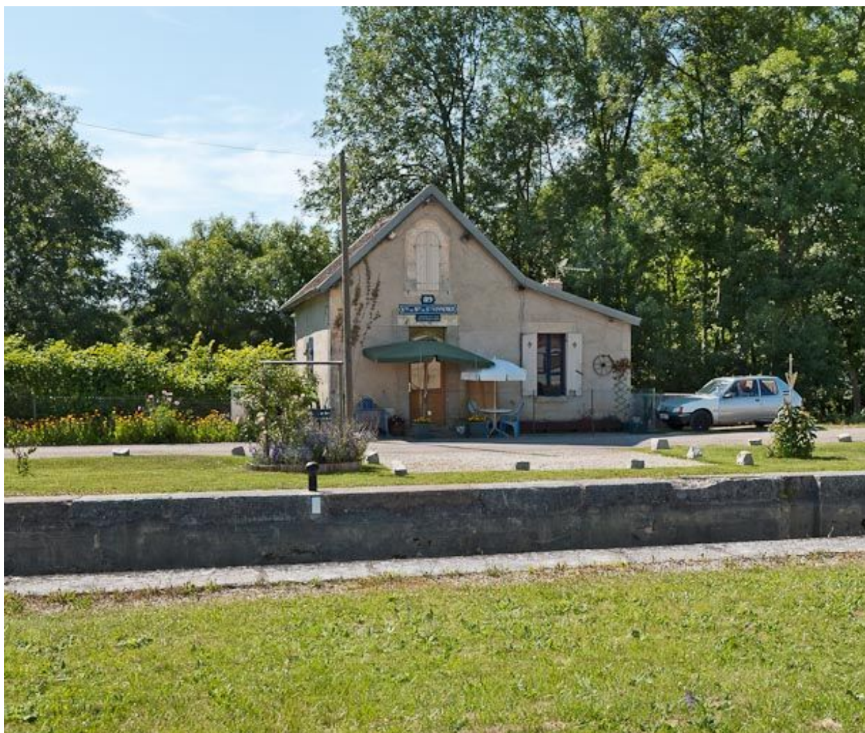
Vue de face de la maison éclusière.
