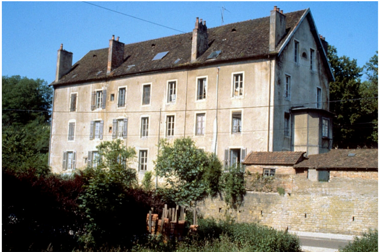
Façade postérieure vue de trois quarts droit.
