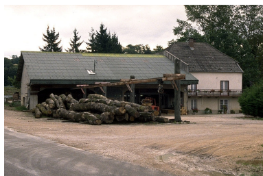
Vue d'ensemble. Phot. Jérôme Mongreville IVR43_19953900410ZA
