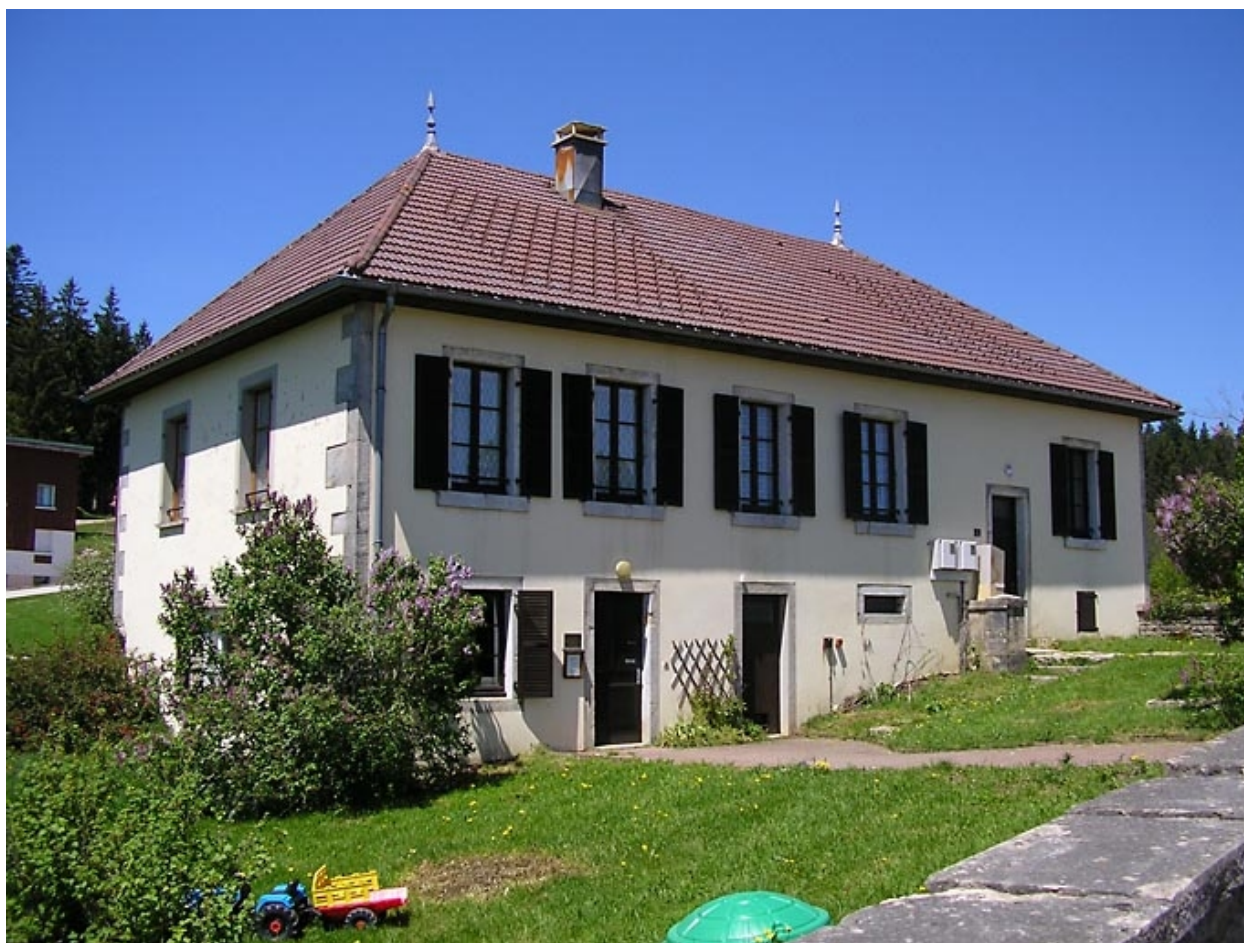
Vue de trois quarts sur façade antérieure.
