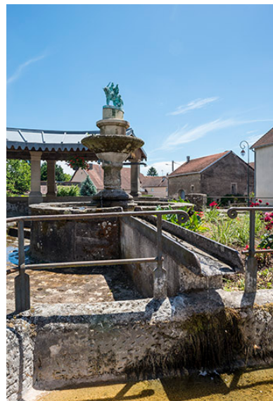
Détail de la fontaine. Phot. Jérôme Mongreville IVR43_20177000800NUC4A
