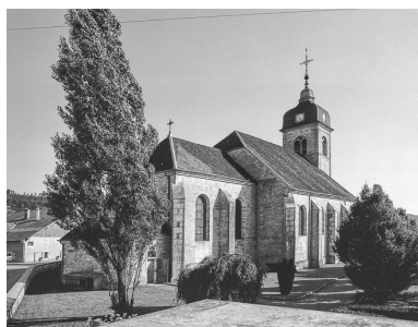
Façade latérale gauche et chevet. Phot. Yves Sancey IVR43_19752500900X
