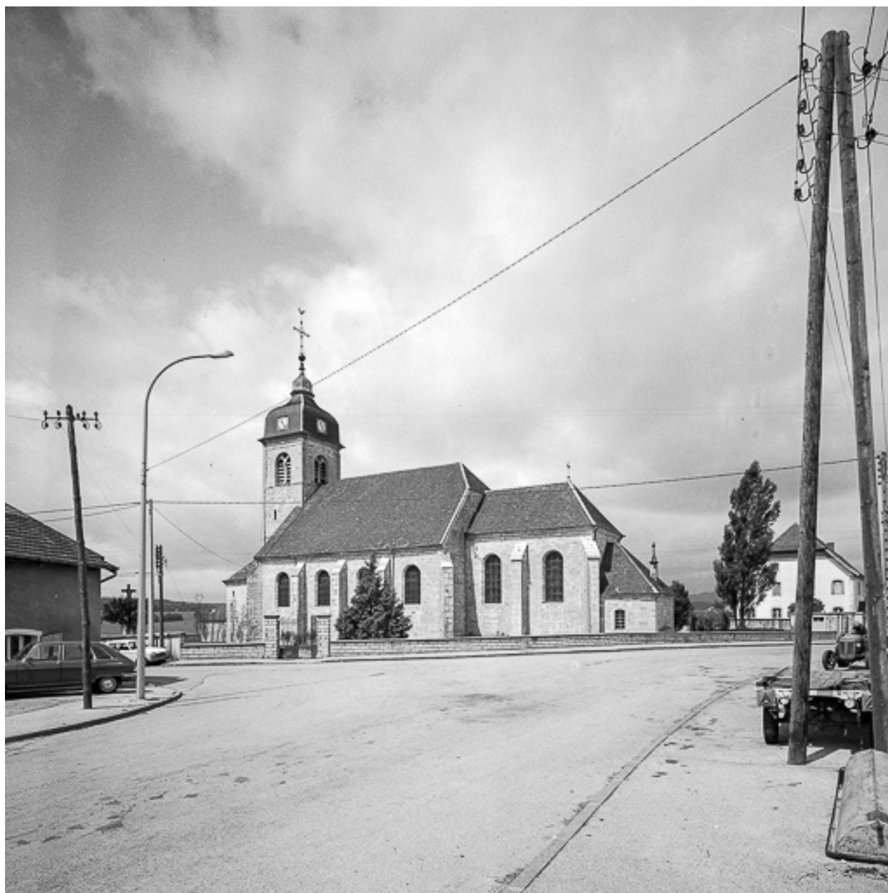
Façade latérale droite.
