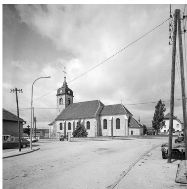
Façade latérale droite. Phot. Yves Sancey IVR43_19752500911V
