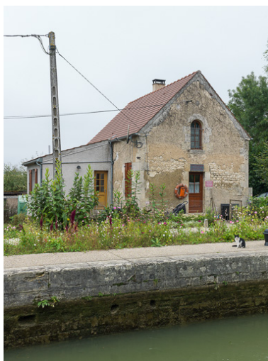
Vue de la maison éclusière.
