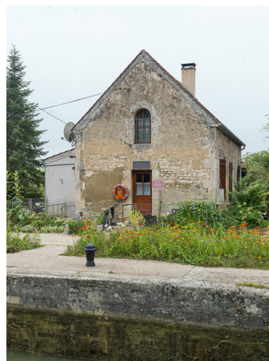
Vue de la maison éclusière.
