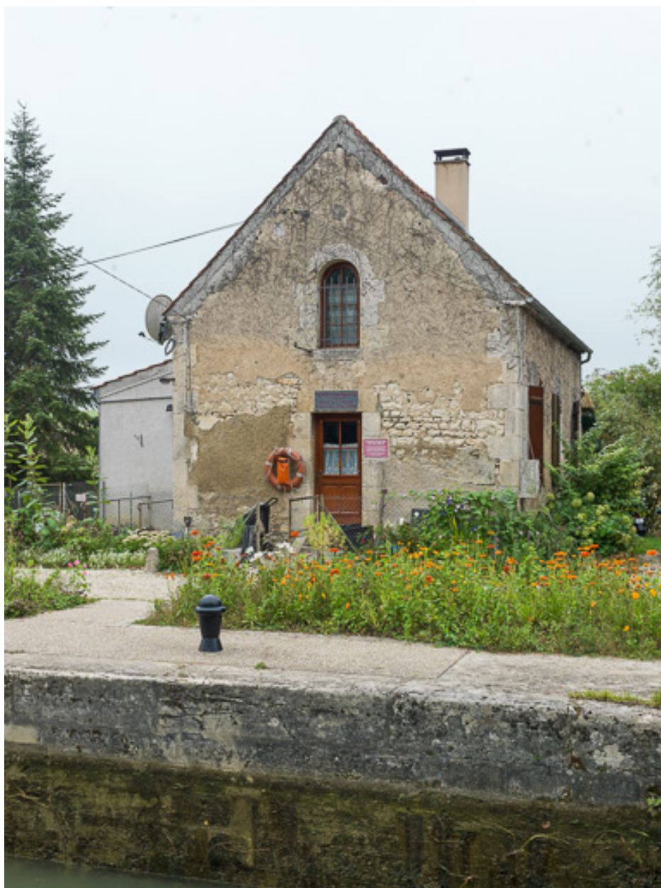
Vue de la maison éclusière.
