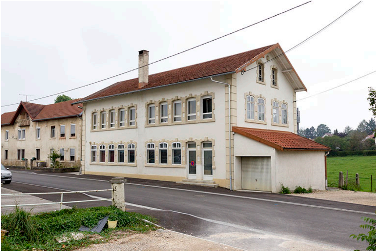
Vue d'ensemble, depuis le nord-est (façades antérieure et latérale droite).
