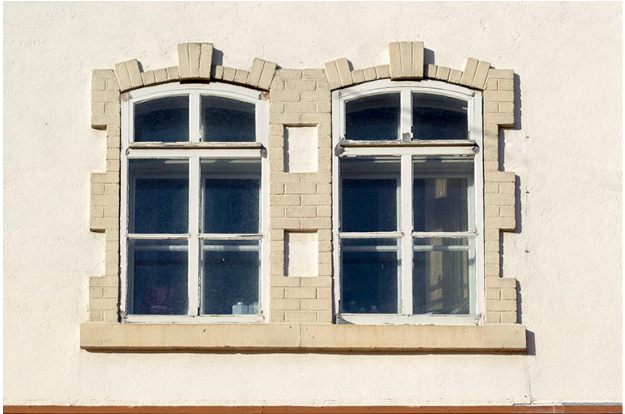
Façade latérale droite : fenêtres horlogère de l'étage carré.
