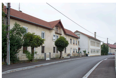
Vue d'ensemble, depuis le sud (façade antérieure).
