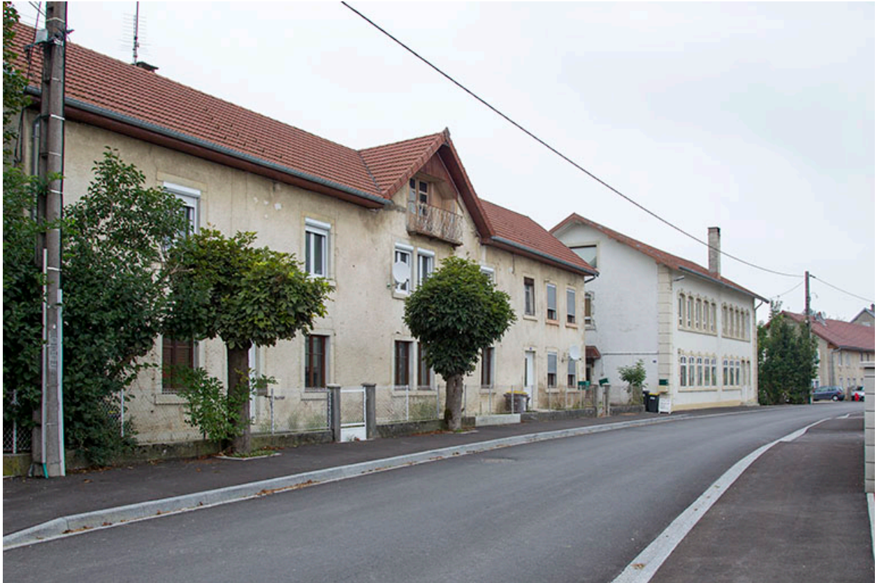
Vue d'ensemble, depuis le sud (façade antérieure).
