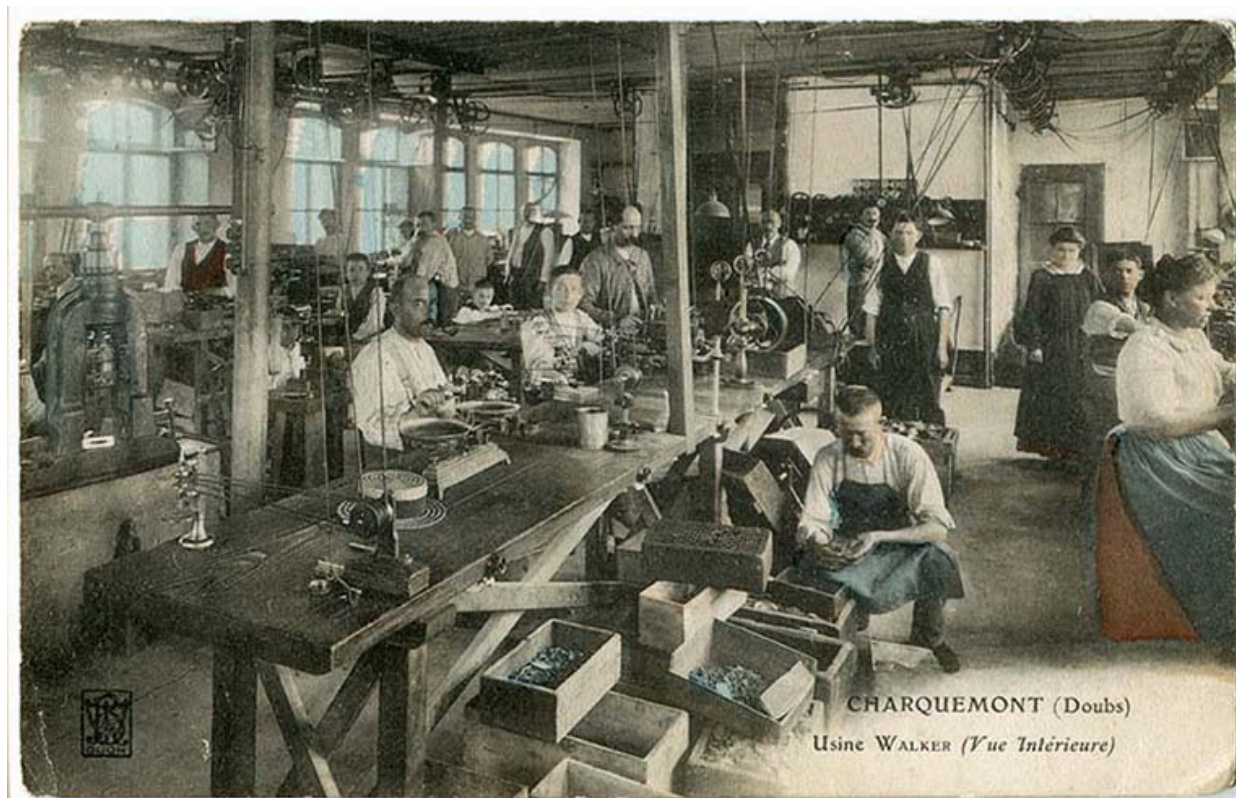
Charquemont (Doubs) - Usine Walker (vue intérieure), entre 1904 et 1907.
