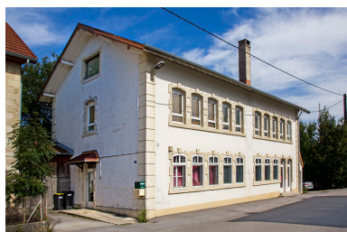
Façades antérieure et latérale gauche.
