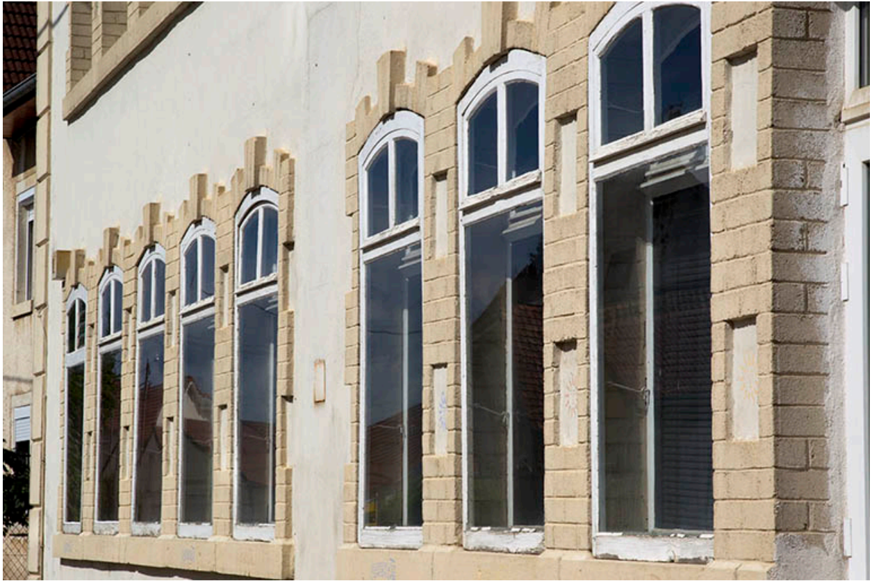
Façade antérieure : fenêtres multiples du rez-de-chaussée vue en enfilade.
