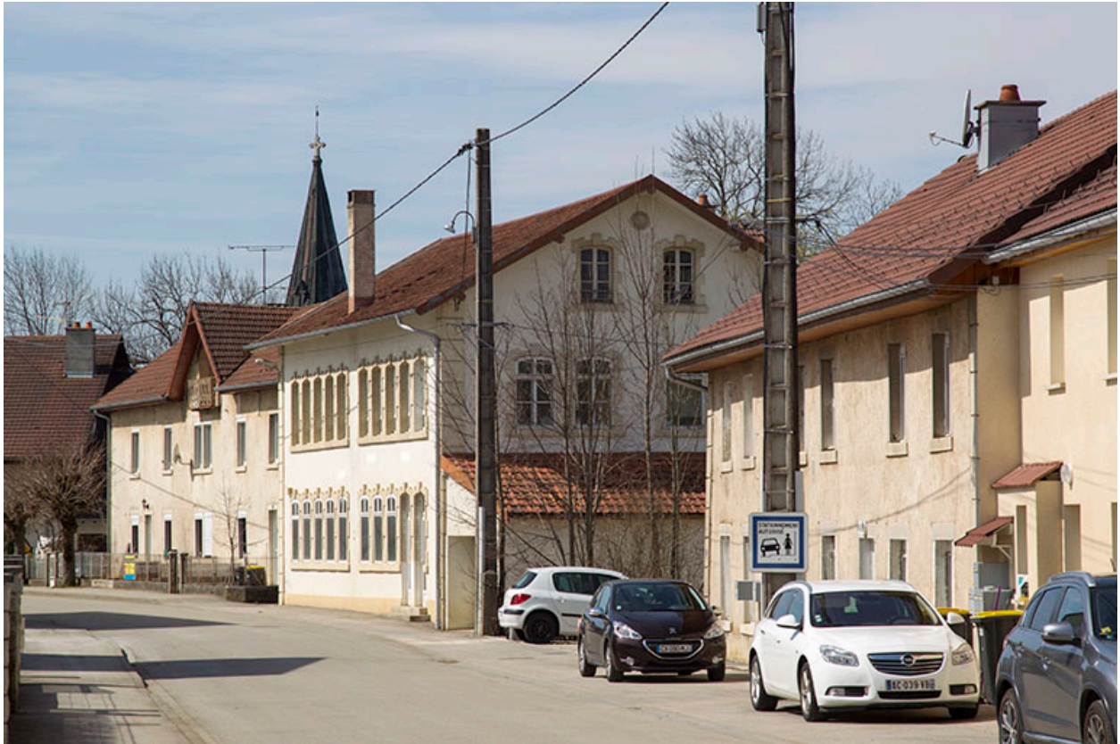
Vue d'ensemble éloignée dans la rue, depuis le nord-est.
