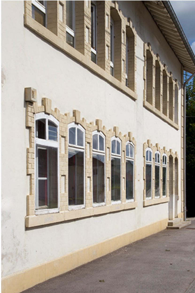
Façade antérieure : fenêtres multiples vues en enfilade.
