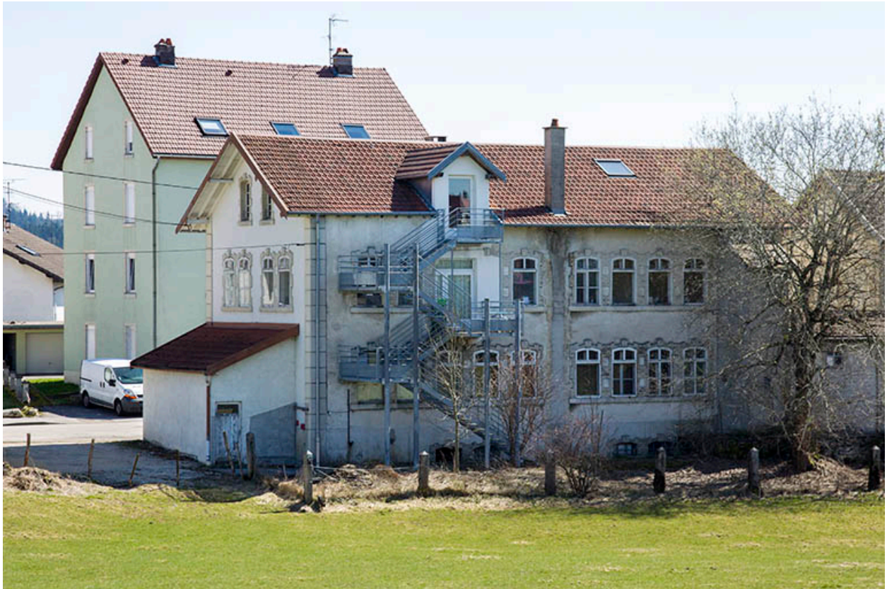
Vue d'ensemble, depuis le nord (façades postérieure et latérale droite).
