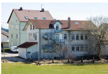
Vue d'ensemble, depuis le nord (façades postérieure et latérale droite).
