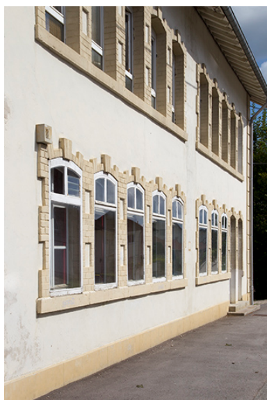
Façade antérieure : fenêtres multiples vues en enfilade.
