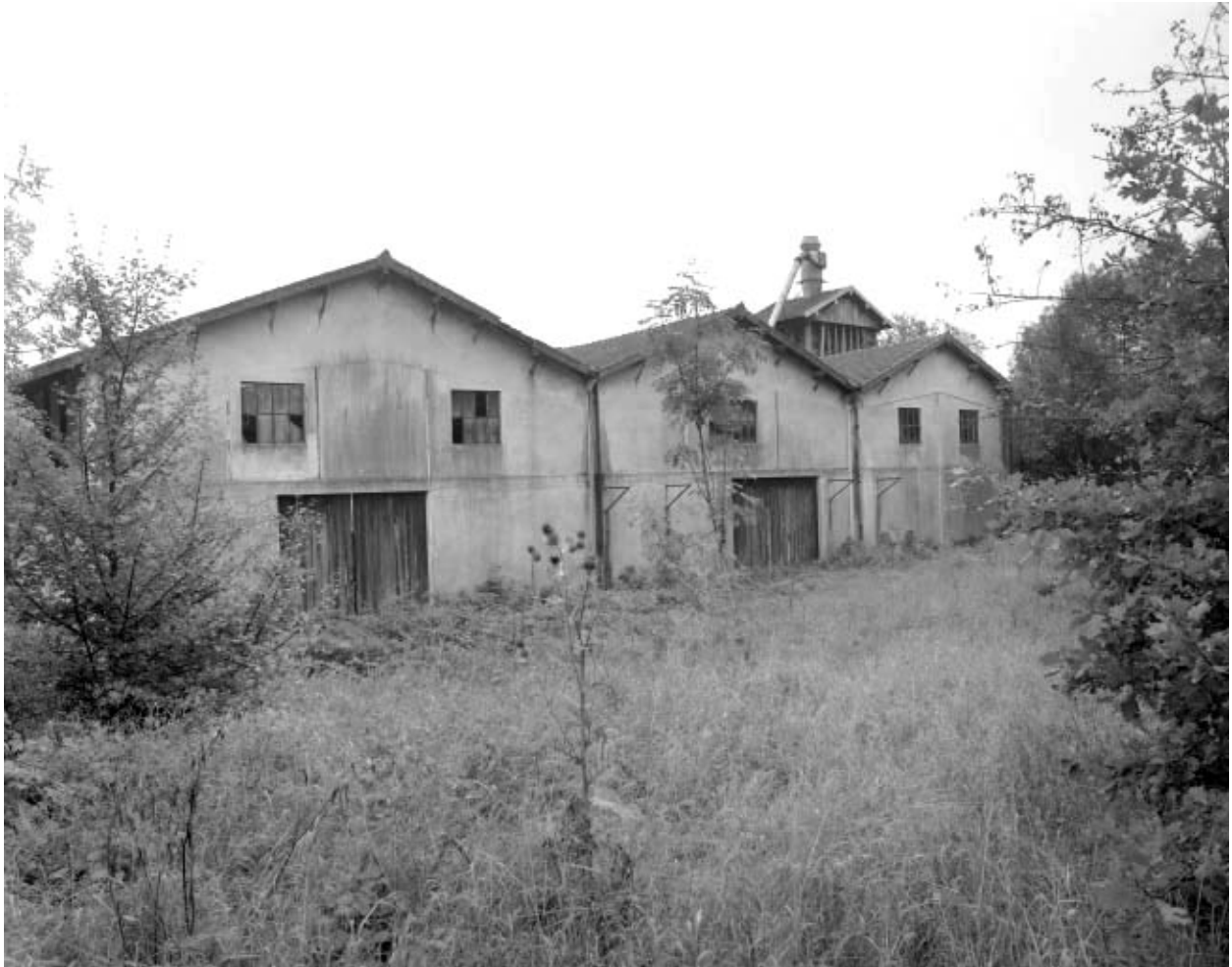
Façade postérieure de l'atelier de fabrication.
