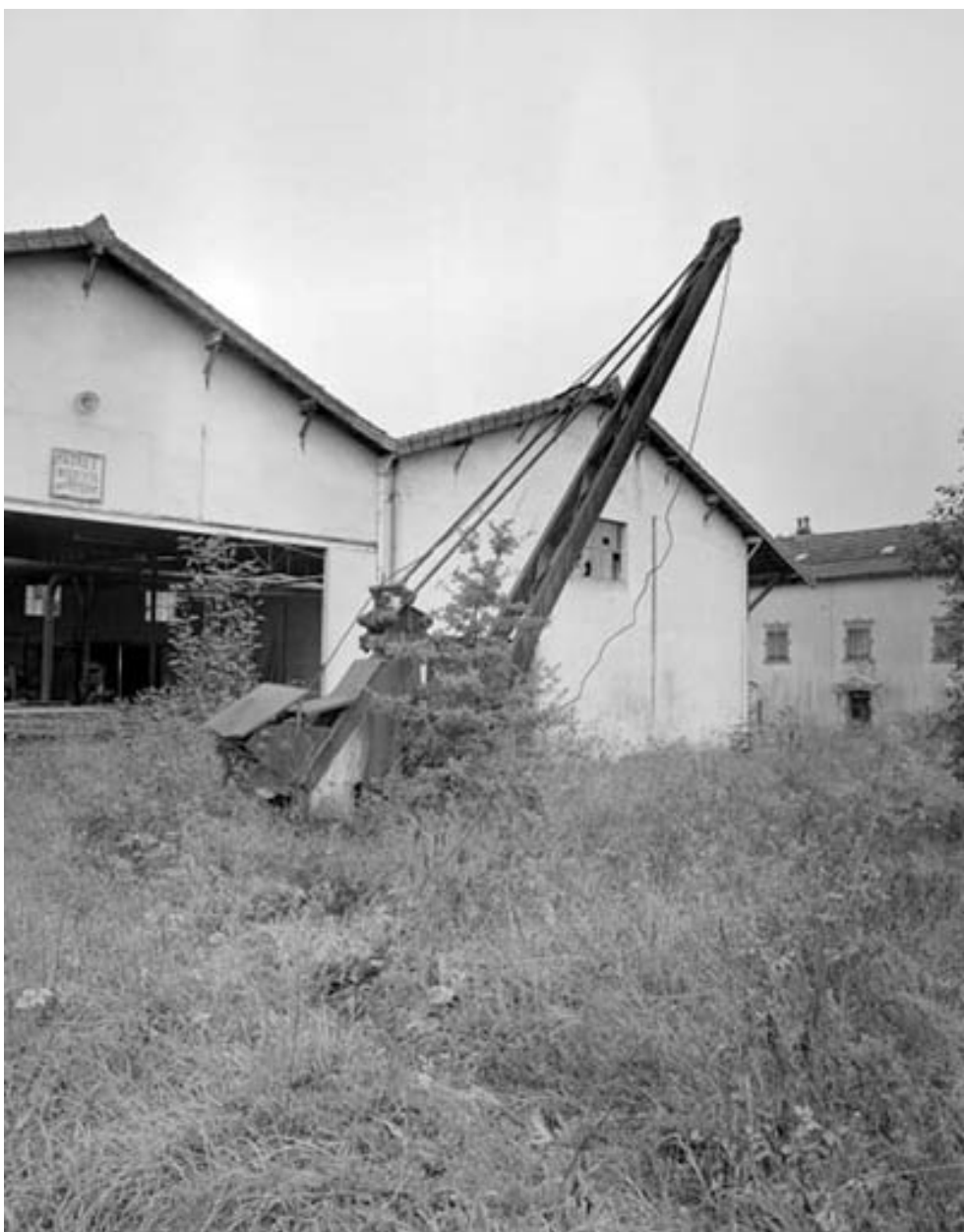
Grue sur l'aire des matières premières.
