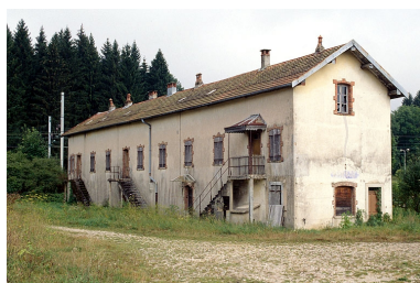
Façade antérieure du logement ouvrier. Phot. Yves Sancey IVR43_19973901469ZA
