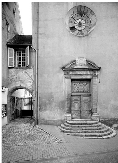
Chapelle : façade antérieure, détail du portail d'entrée avec l'oculus en 1989. Phot. Yves Sancey IVR43_19897000128V
