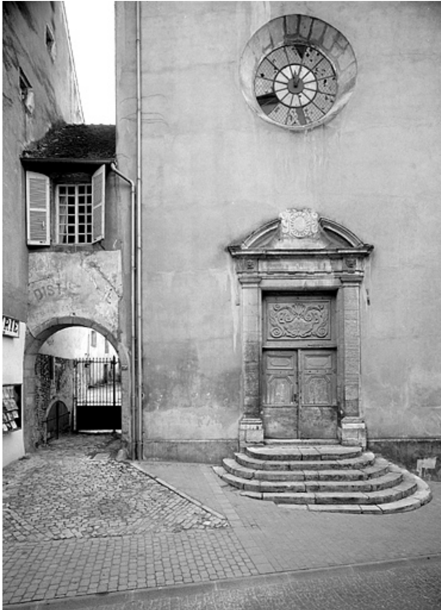
Chapelle : façade antérieure, détail du portail d'entrée avec l'oculus en 1989.
