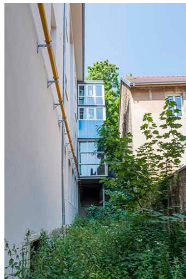
Façade est des espaces de distribution du centre de documentation et d'information.
