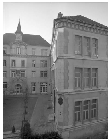
Aile droite et façade antérieure du bâtiment principal en 1989. Phot. Yves Sancey IVR43_19897000122X
