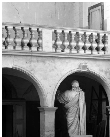
Chapelle : intérieur, détail d'un arc et de la clôture de la tribune en 1989. Phot. Yves Sancey IVR43_19897000139X
