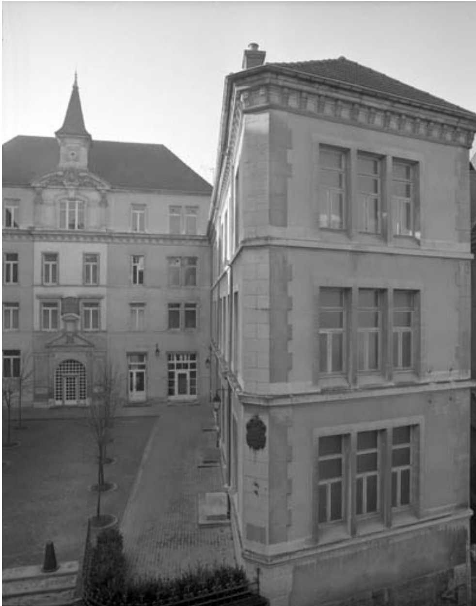
Aile droite et façade antérieure du bâtiment principal en 1989.
