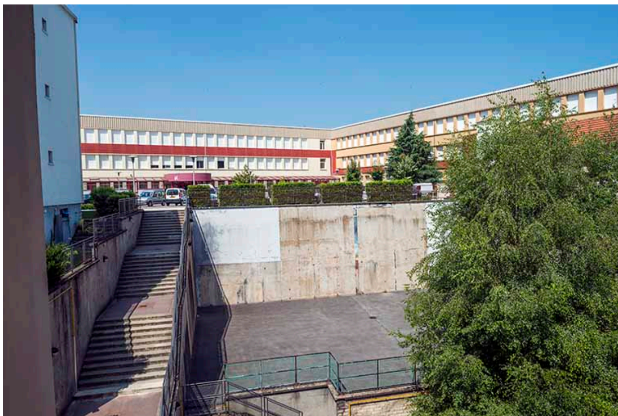
Escalier desservant la petite cour d'honneur, chaufferie, cour, angle intérieur nord ouest des bâtiments d'externat.
