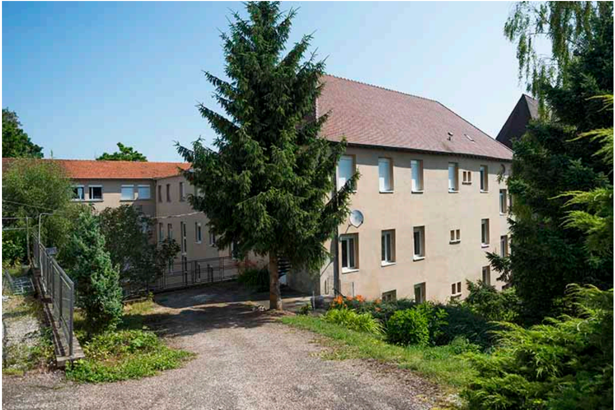
Angle sud-ouest du bâtiment d'administration.
