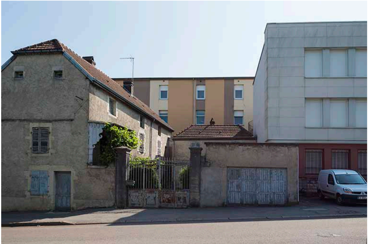
Détail de l'angle nord de la façade postérieure ouest sur la rue de l'arsenal.
