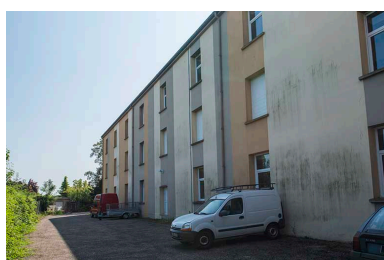
Façade nord de la barre d'externat nord. Phot. Mary Ruffinoni IVR43_20137000906NUC4A
