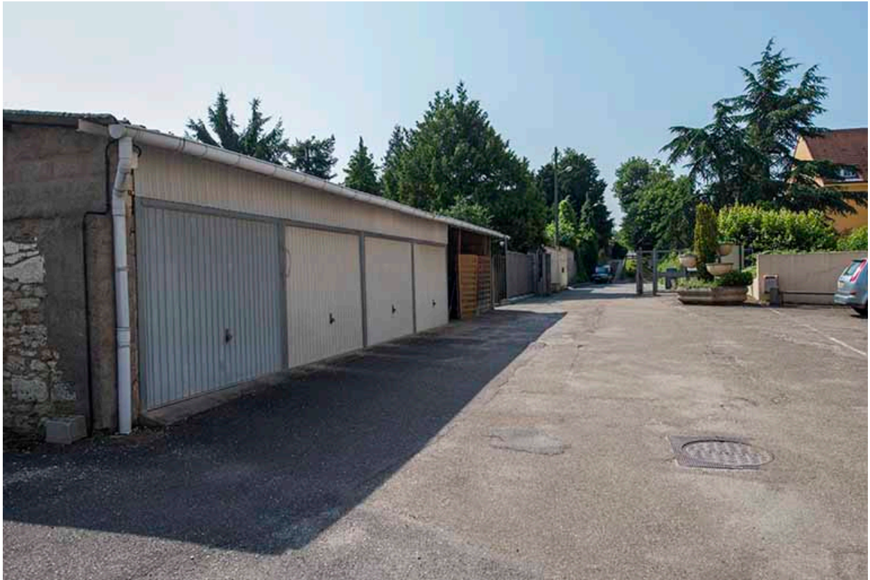
Entrée et garages.
