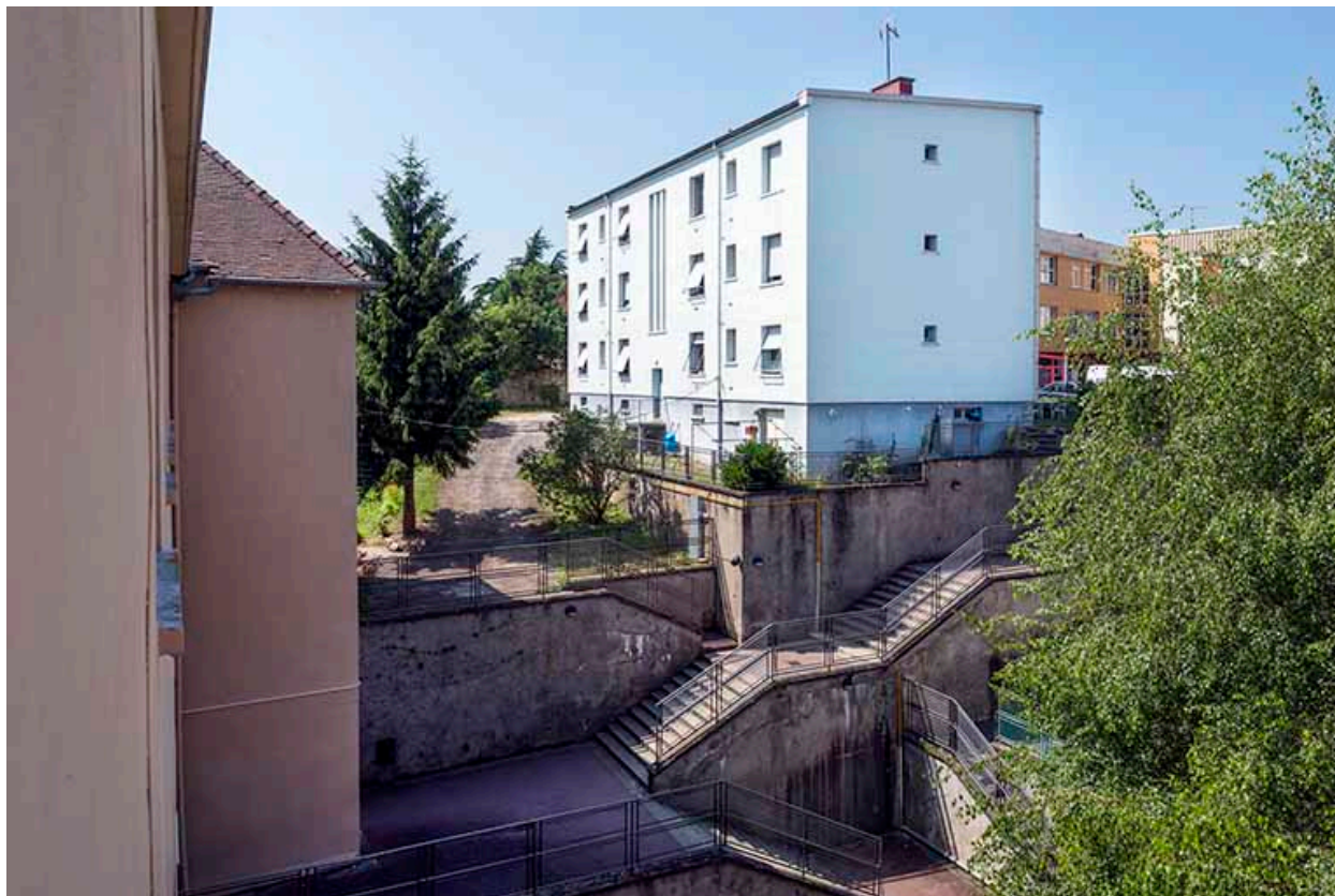
Angle nord-est des logements et escaliers entre la petite cour d'honneur et la cour.
