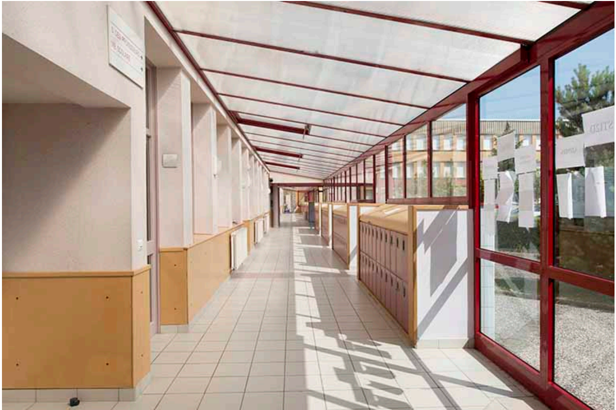
Couloir de la barre d'externat ouest.
