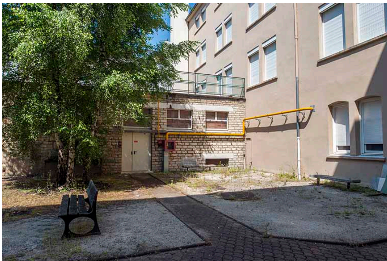
Angle nord-ouest de la petite cour d'honneur, chaufferie, ancien internat.
