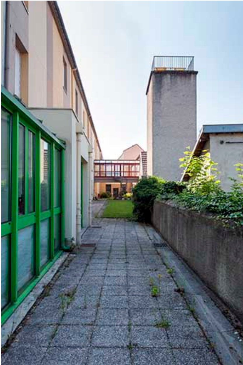
Façade postérieure ouest de la barre d'externat ouest.
