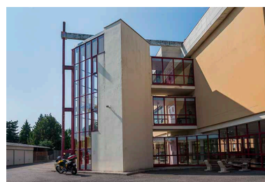
Détail de l'escalier dit le phare. Phot. Mary Ruffinoni IVR43_20137000897NUC4A
