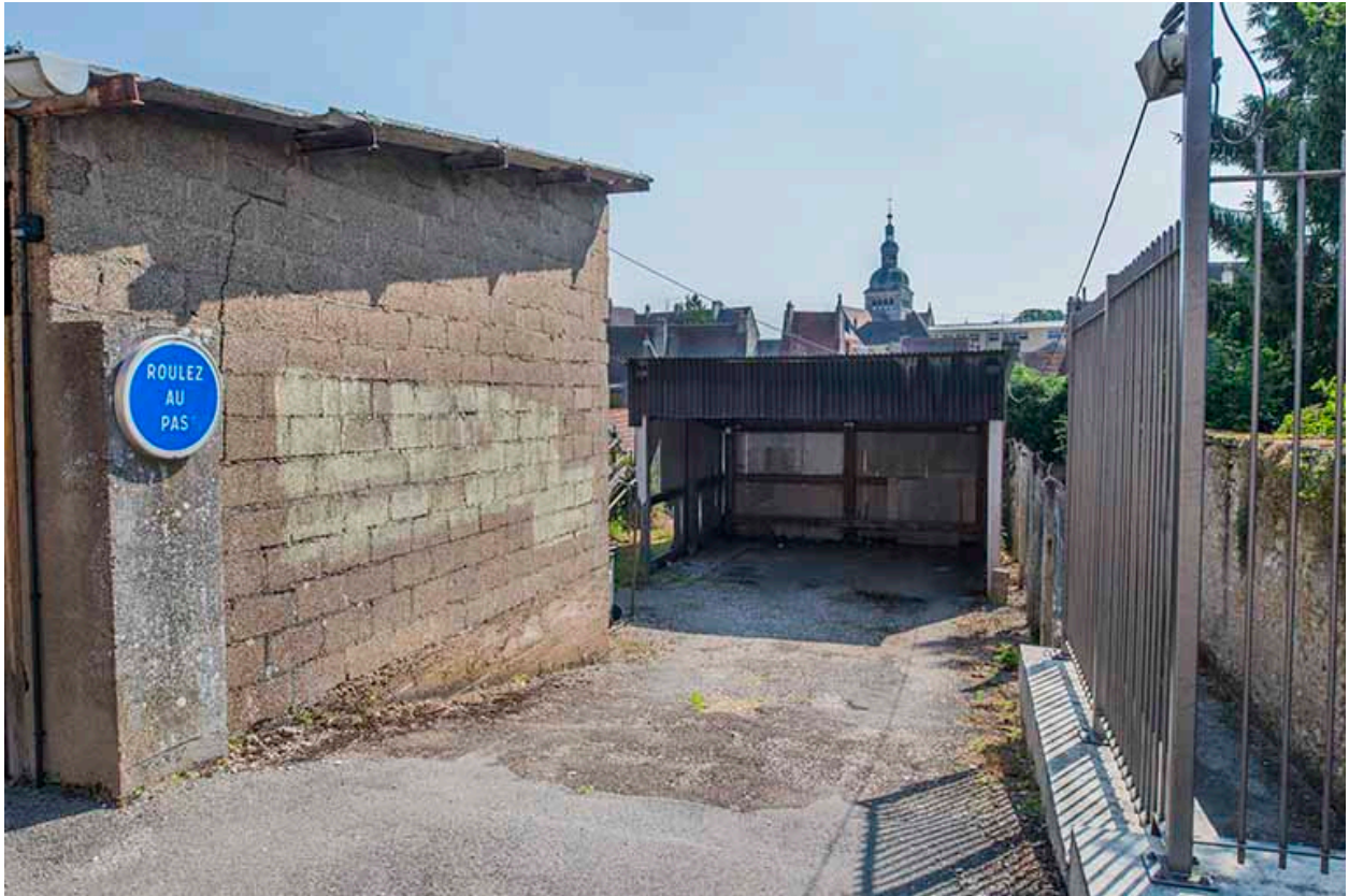
Détail de façade sud des garages et entrée ouest du garage des ouvriers.
