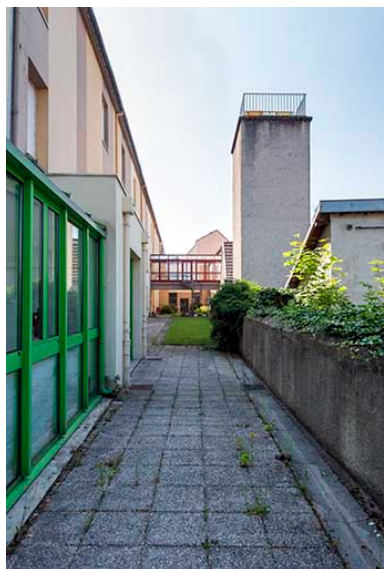
Façade postérieure ouest de la barre d'externat ouest. Phot. Mary Ruffinoni IVR43_20137000907NUC4A
