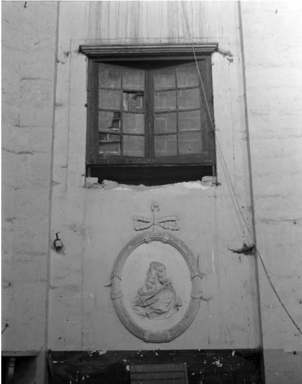
Chapelle : intérieur, façade latérale droite avec médaillon de saint Paul? surmonté d'une baie murée en 1989.
