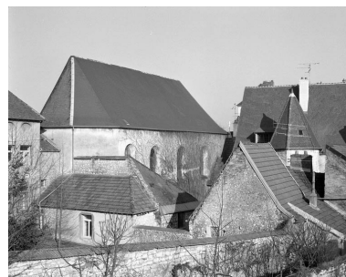
Chapelle : chevet et façade latérale gauche depuis l'arrière de l'hôtel de Conflans, vue rapprochée en 1989. Phot. Yves Sancey IVR43_19897000147X
