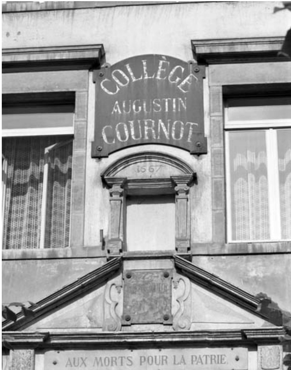
Façade antérieure du bâtiment principal : détail de la niche au dessus du portail d'entrée en 1989.
