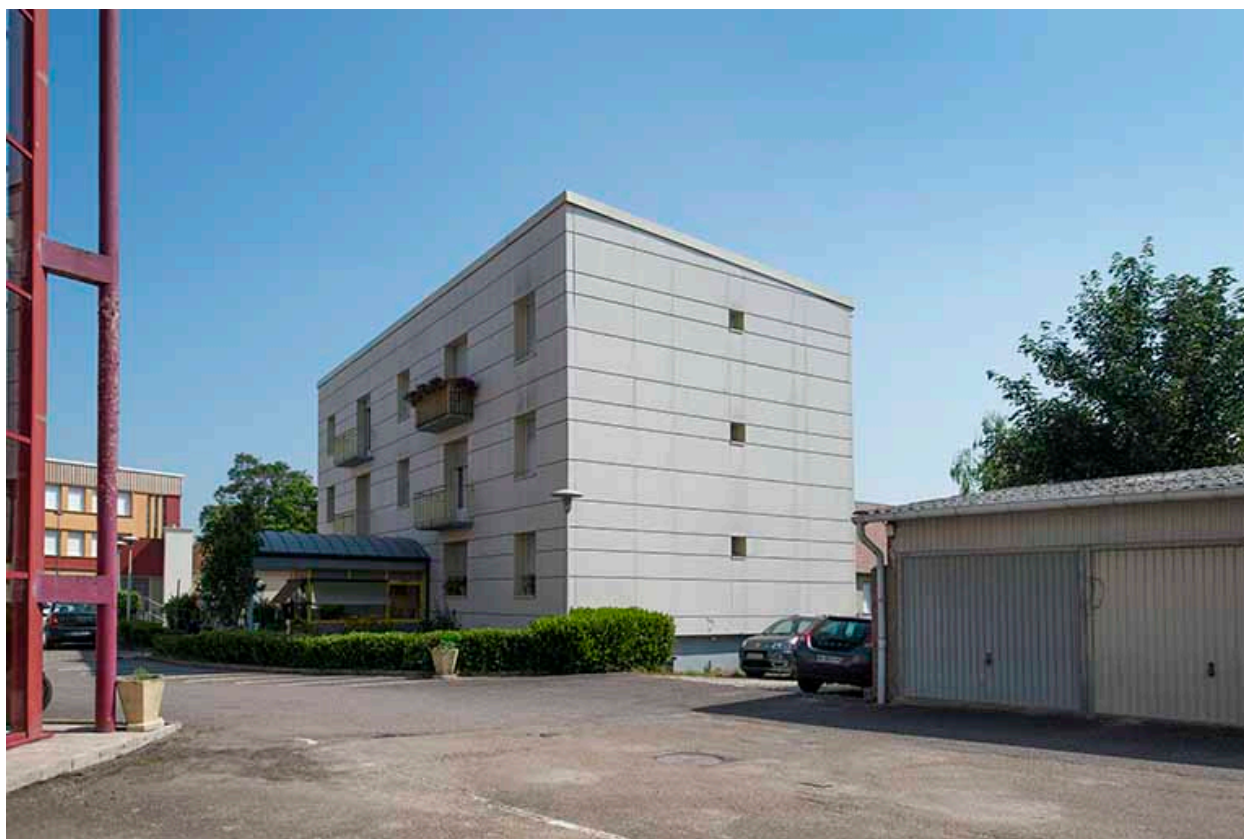
Angle sud-ouest du bâtiment d'accueil, de la loge et des logements.
