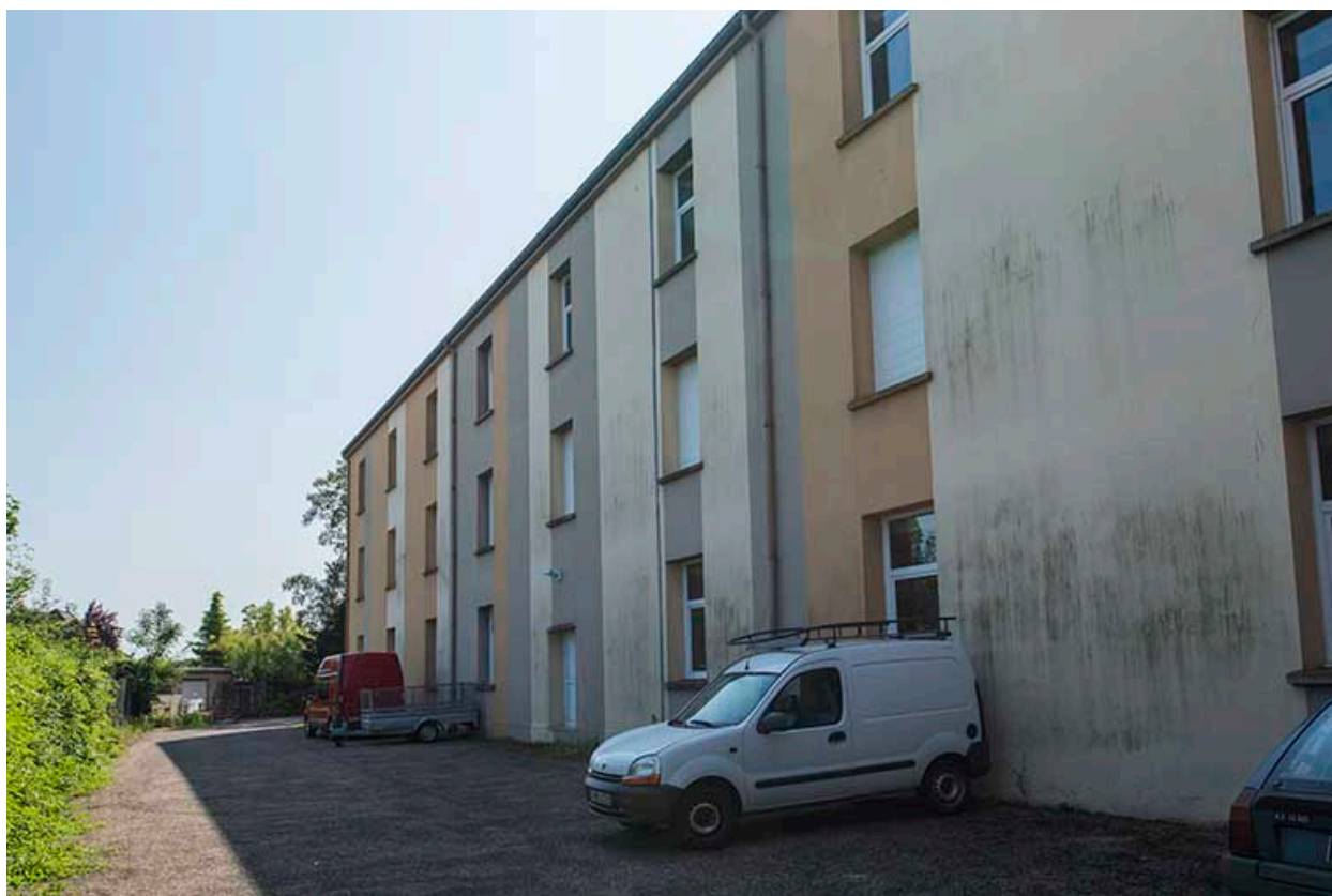
Façade nord de la barre d'externat nord.
