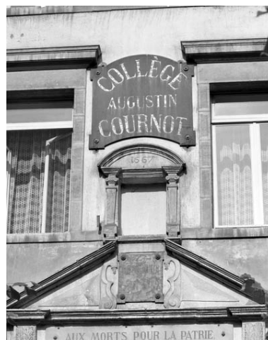
Façade antérieure du bâtiment principal : détail de la niche au dessus du portail d'entrée en 1989.
