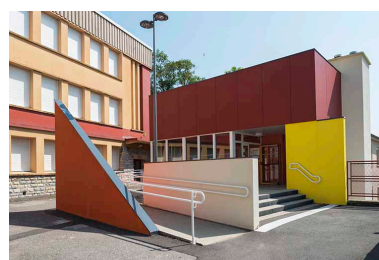
Angle est de la barre d'externat nord et entrée du centre de documentation et d'information. Phot. Mary Ruffinoni IVR43_20137000904NUC4A
