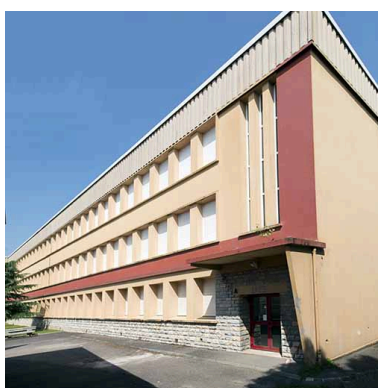
Angle sud-est de la barre d'externat nord. Phot. Mary Ruffinoni IVR43_20137000920NUC4A
