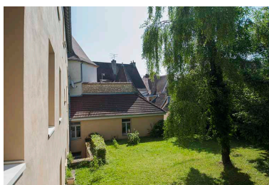
Angle nord-est du jardin, façades ouest du bâtiment des archives, façade sud du bâtiment d'administration. Phot. Mary Ruffinoni IVR43_20137000903NUC4A
