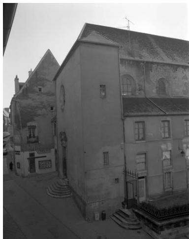
Chapelle : façade antérieure de trois quarts droit en 1989. Phot. Yves Sancey IVR43_19897000127X
