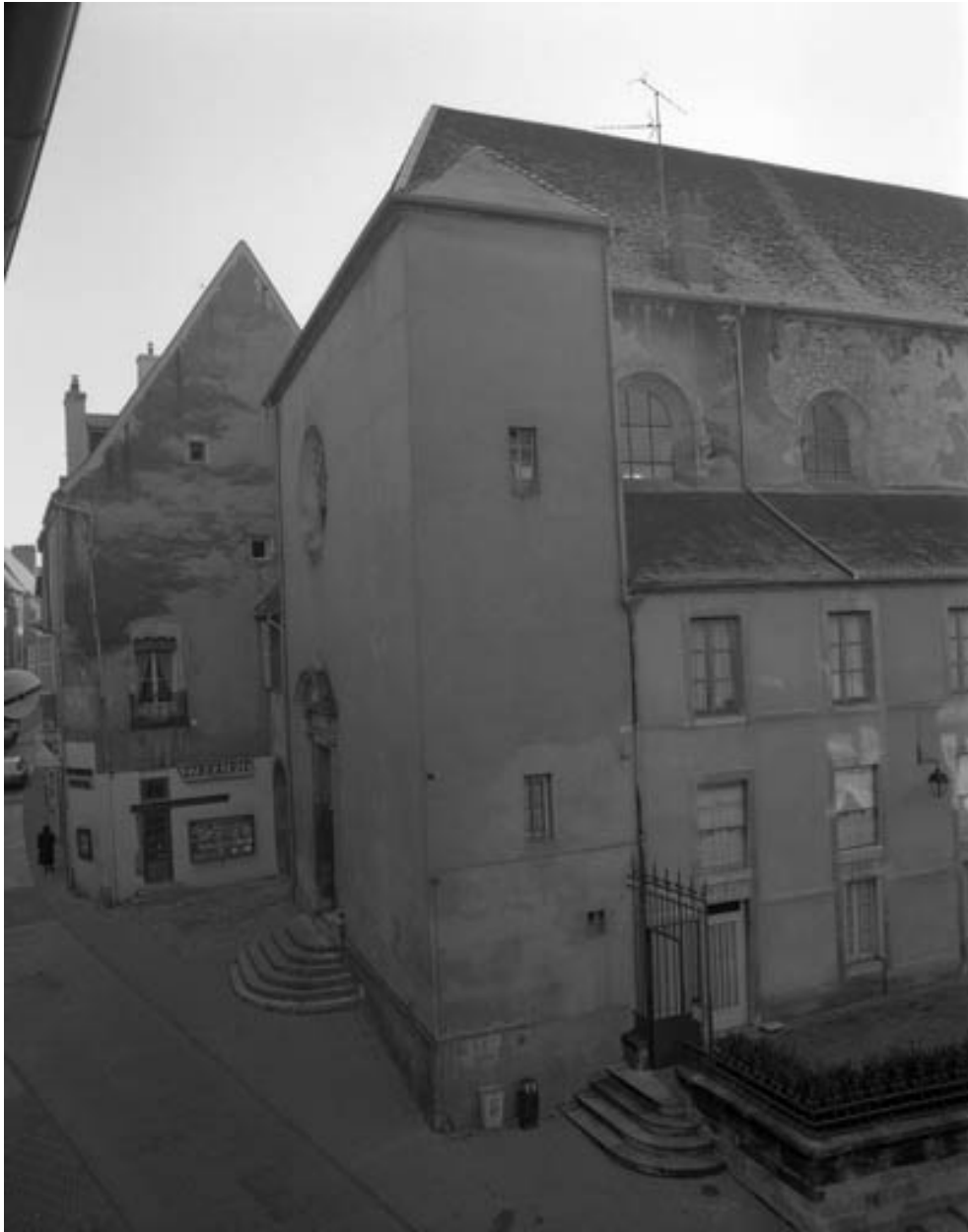
Chapelle : façade antérieure de trois quarts droit en 1989.
