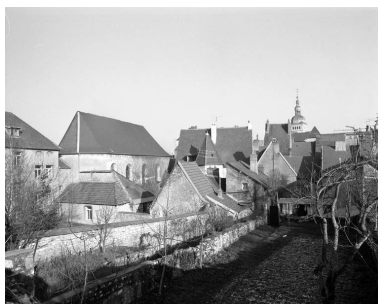
Chapelle : chevet et façade latérale gauche depuis l'arrière de l'hôtel de Conflans en 1989. Phot. Yves Sancey IVR43_19897000146X
