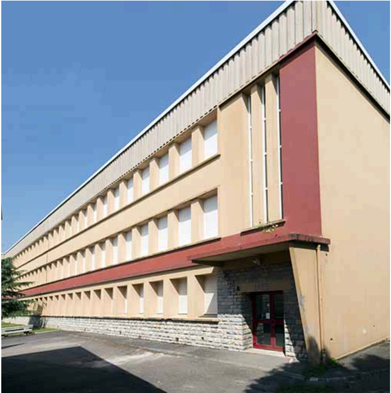
Angle sud-est de la barre d'externat nord.
