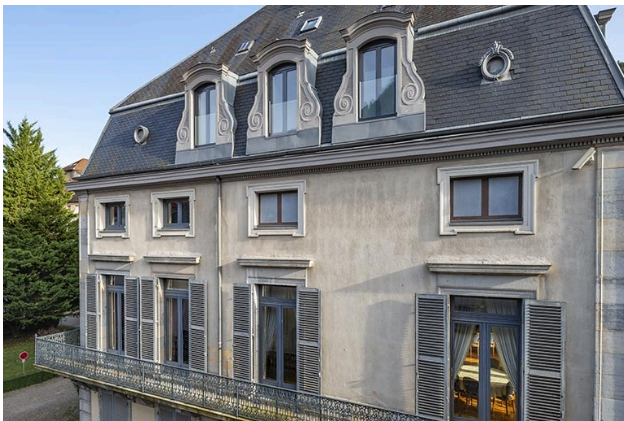
Façade ouest, détail.
