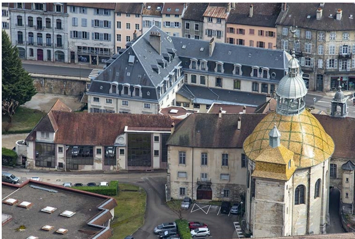
Vue depuis l'ouest.
