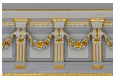
Salle de restaurant, triglyphes à enroulement formant modillon, ornés de guirlandes végétales. Phot. Jérôme Mongreville IVR43_20213900252NUC4A
