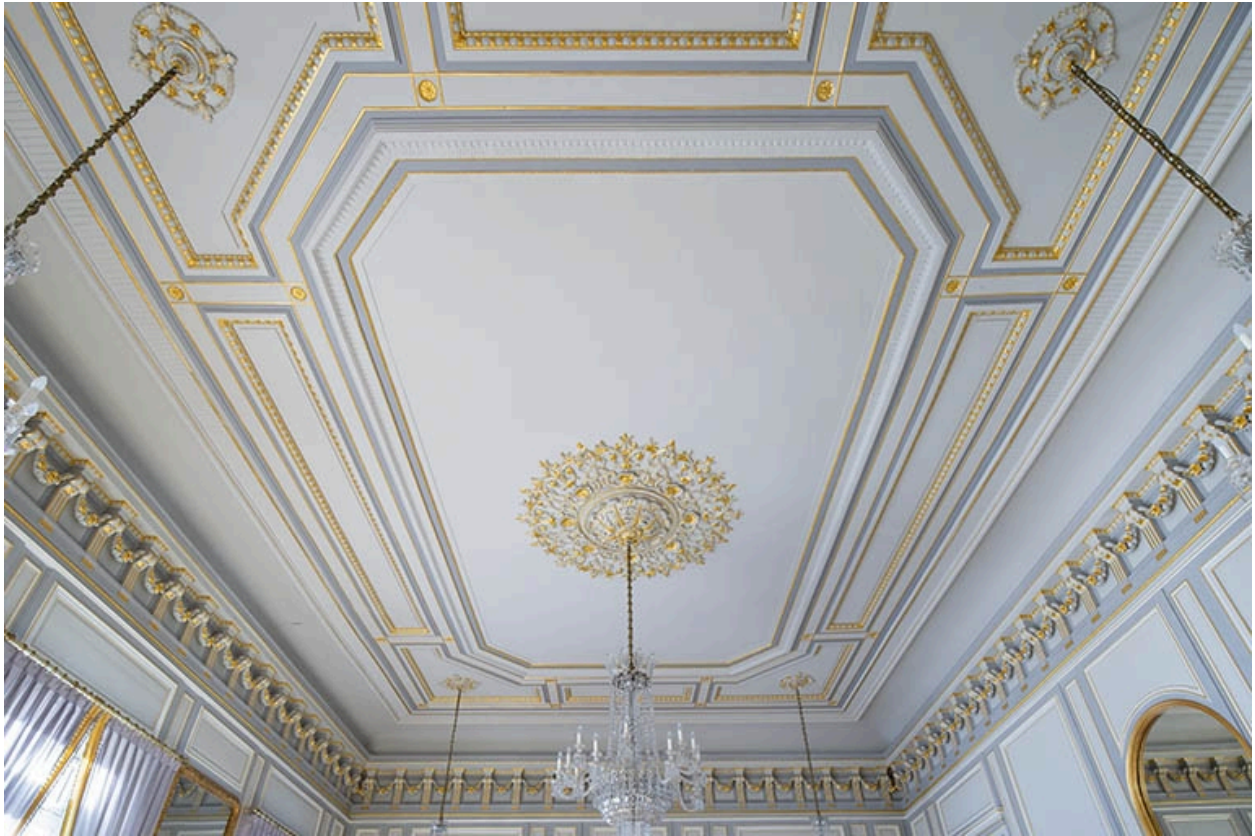
Salle de restaurant, plafond.
