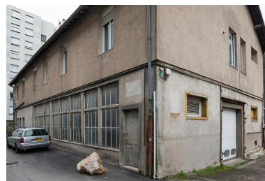
Atelier de fabrication. Phot. Jérôme Mongreville IVR43_20172501390NUC4A
