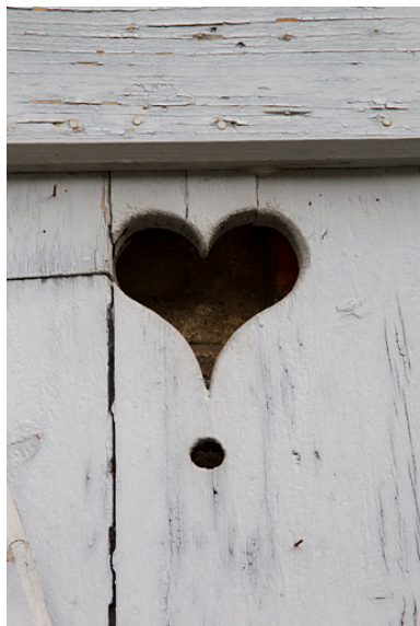
Bâtiment de la distillerie : motif en coeur sur un volet.
