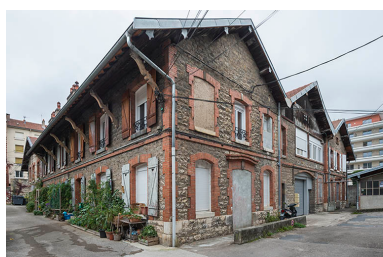
Bâtiment de la distillerie, depuis le sud.
