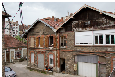
Pignons ouest de la distillerie.
