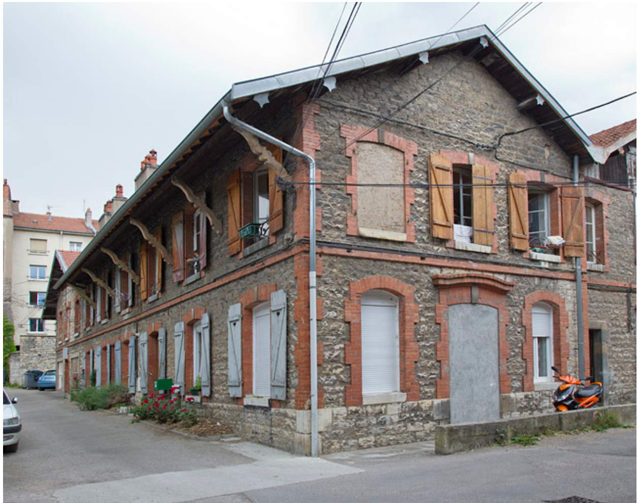
Distillerie : bâtiment sur la ruelle, vu depuis le sud.
