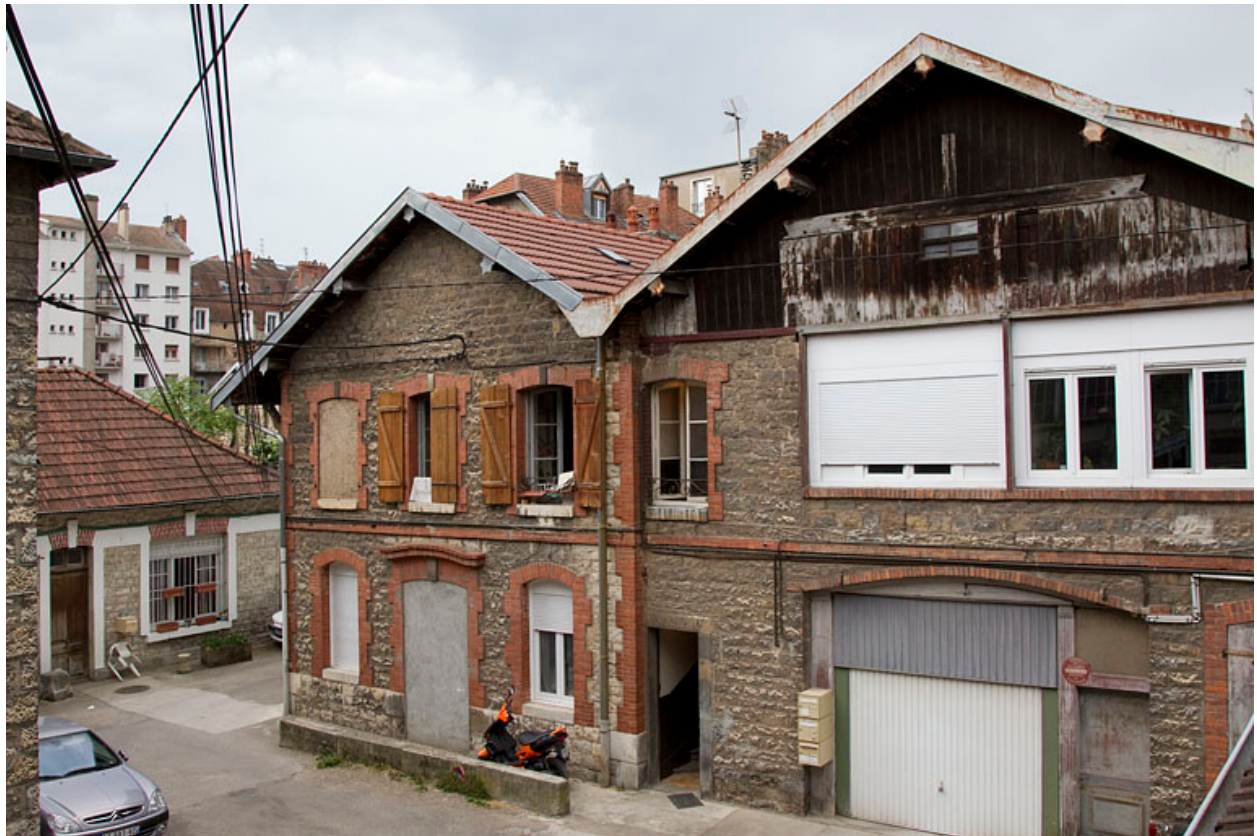
Pignons ouest de la distillerie.
