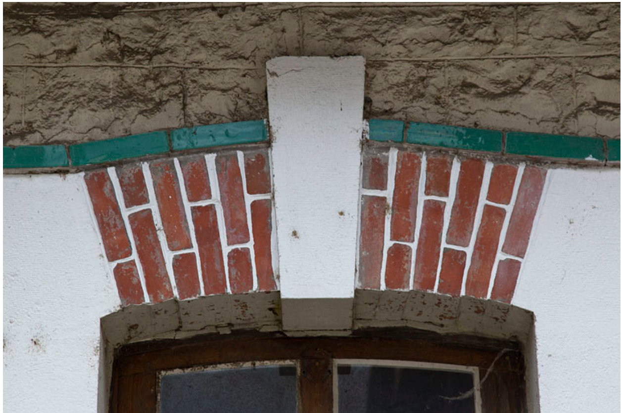
Atelier de fabrication (?). Arc en brique couvrant une baie.
