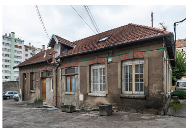
Logement et atelier de fabrication (?). Phot. Jérôme Mongreville IVR43_20172501395NUC4A
