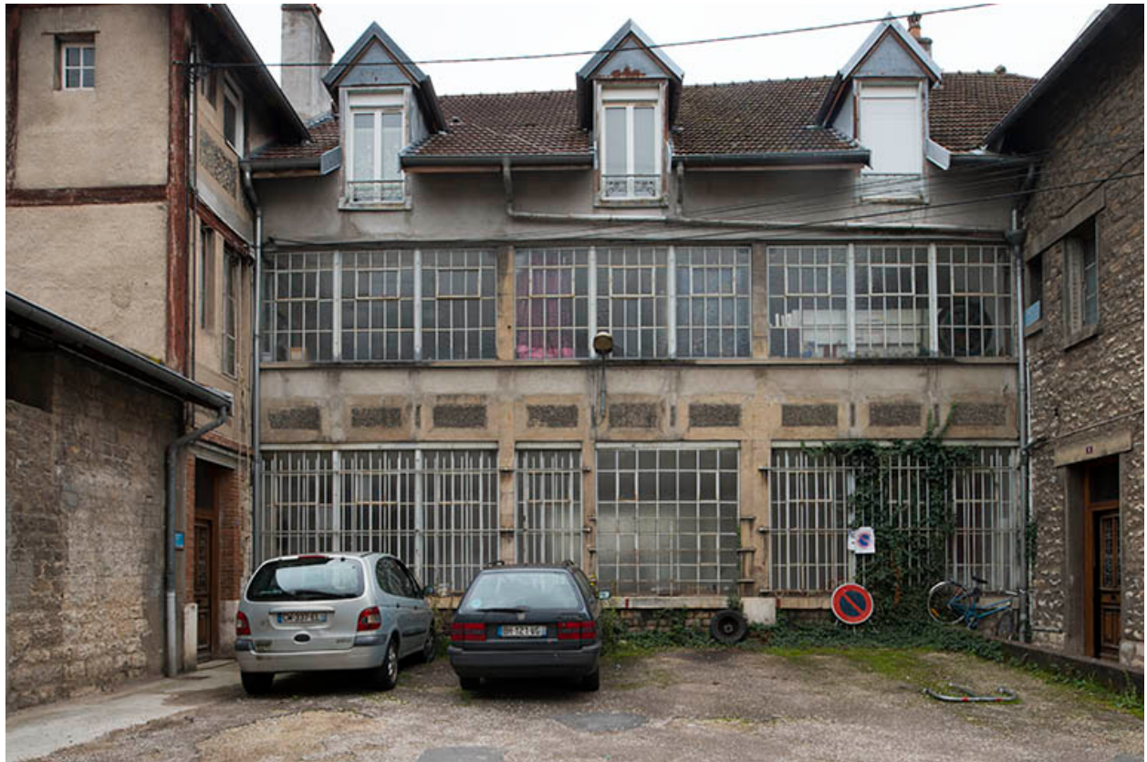
Façade nord d'un atelier de fabrication.
