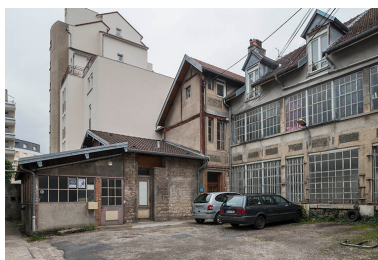
Bâtiments industriels vus depuis la cour. Phot. Jérôme Mongreville IVR43_20172501399NUC4A
