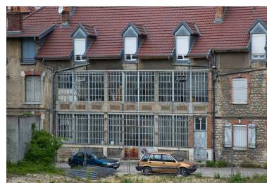
Façade postérieure de l'atelier de fabrication.
