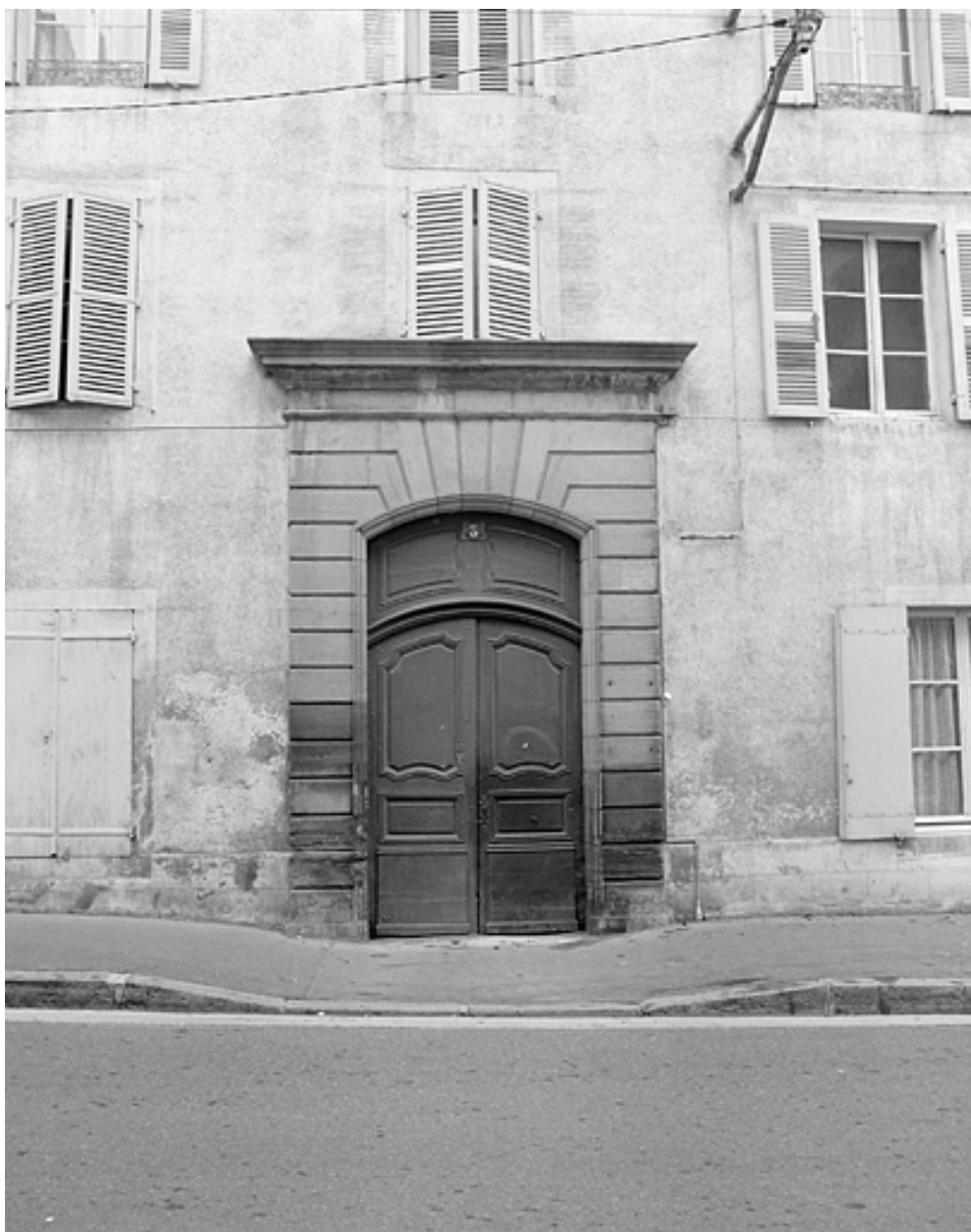
Façade antérieure, portail.
