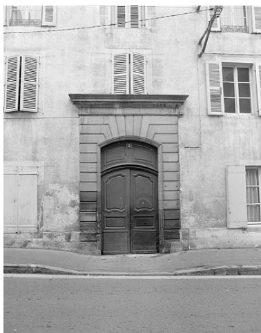
Façade antérieure, portail. Phot. Yves Sancey IVR43_19833900655X
