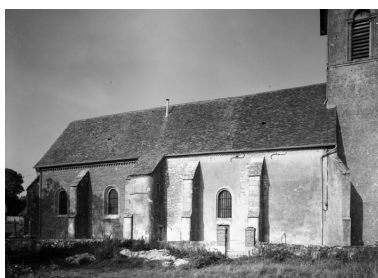
Elévation droite Phot. Michel Thierry IVR26_19852101503V
