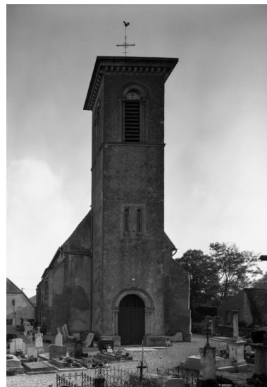
Elévation antérieure Phot. Michel Thierry IVR26_19852101498V
