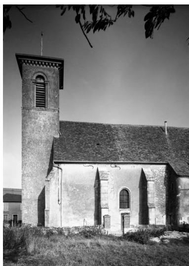
Clocher et élévation droite Phot. Michel Thierry IVR26_19852101502V
