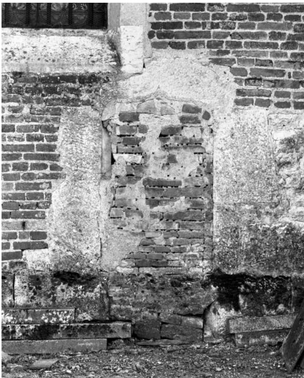
Elévation gauche, porte murée
