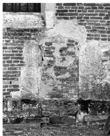
Elévation gauche, porte murée Phot. Jean-Luc Duthu IVR26_19852101501X
