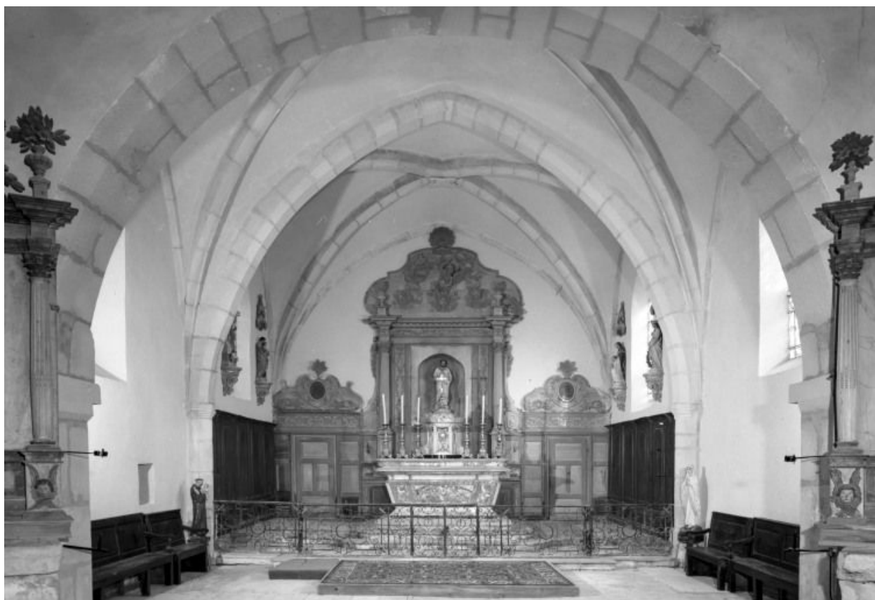
Choeur, vue intérieure
