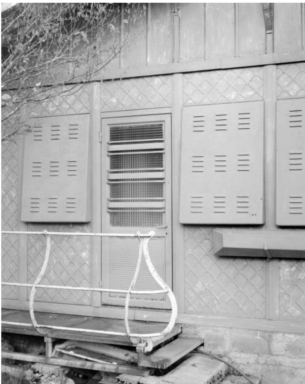
Façade latérale droite.
