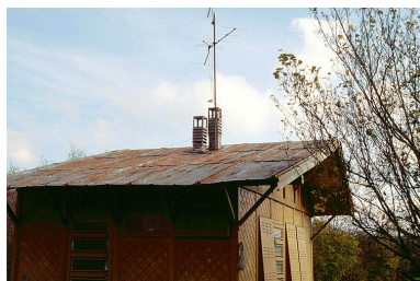
Toiture et cheminées. Phot. Yves Sancey IVR43_19943901591ZA
