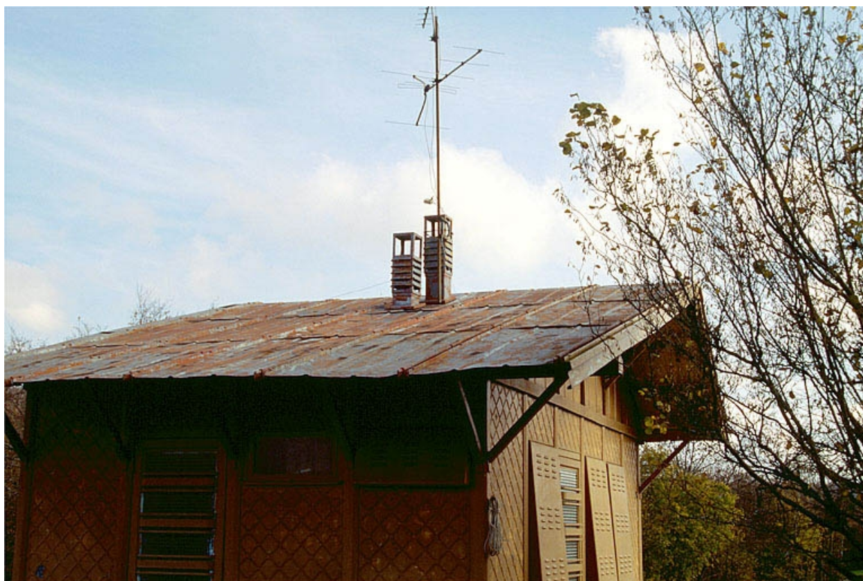
Toiture et cheminées.
