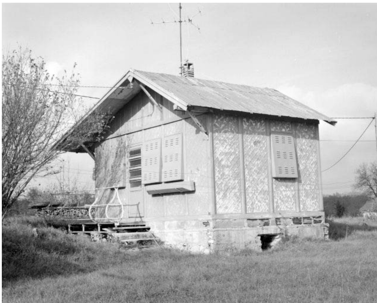
Façades latérale droite et postérieure.
