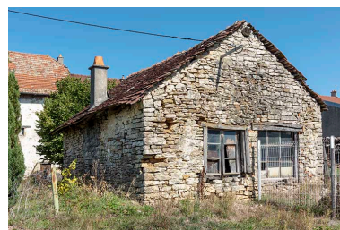
Forge : façade postérieure, de trois quarts gauche. Phot. Sonia Dourlot IVR43_20192501387NUC4A
