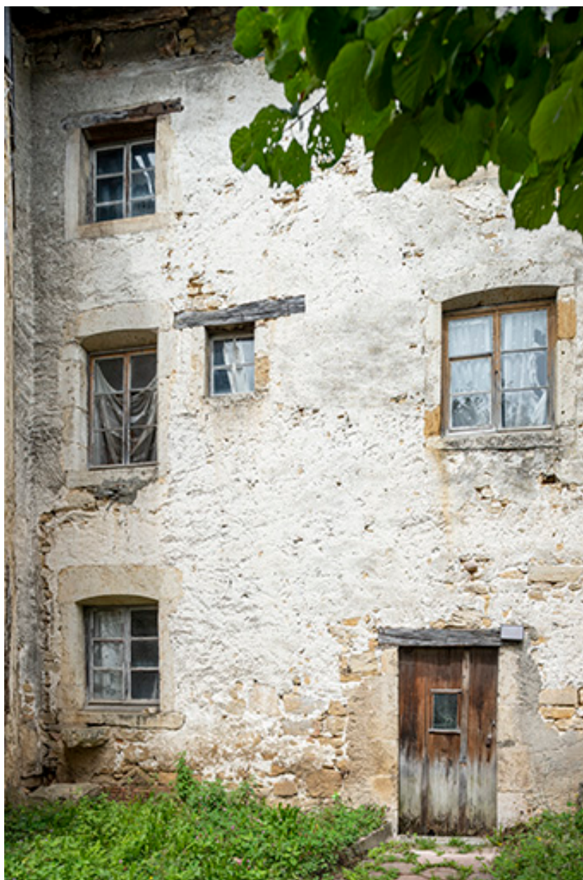
Maison : façade postérieure, de trois quarts.
