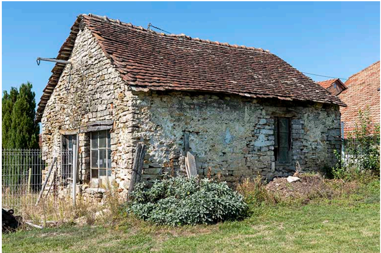
Forge : façades postérieure et latérale gauche.
