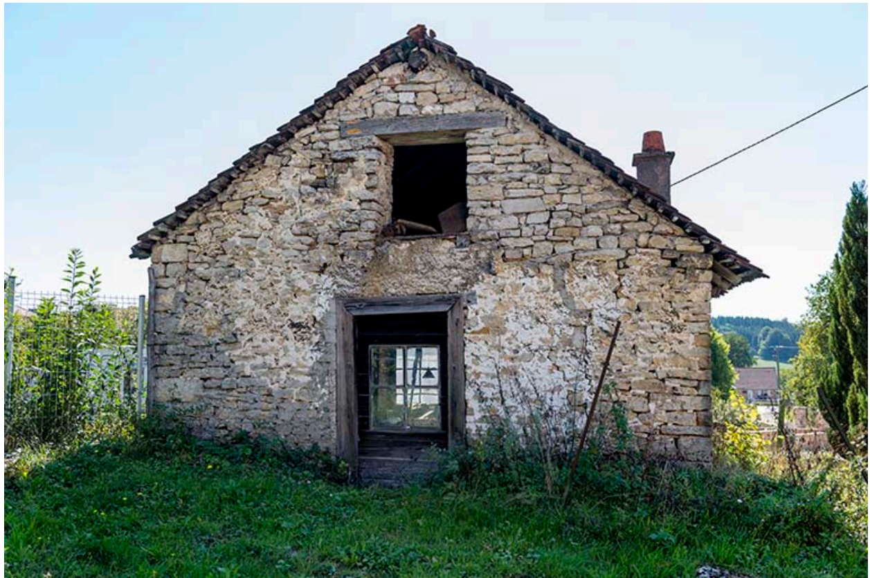
Forge : façade antérieure.
