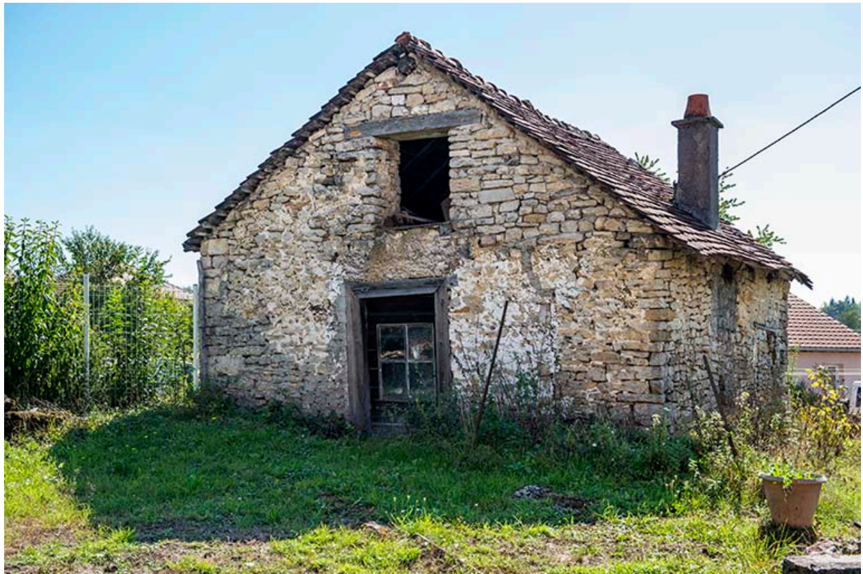
Forge : façade antérieure, de trois quarts droite.
