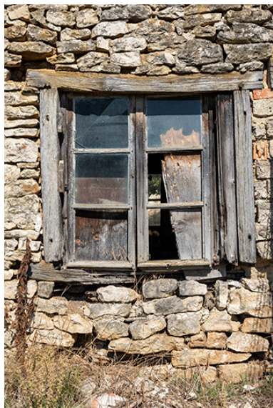
Forge, façade postérieure : fenêtre. Phot. Sonia Dourlot
