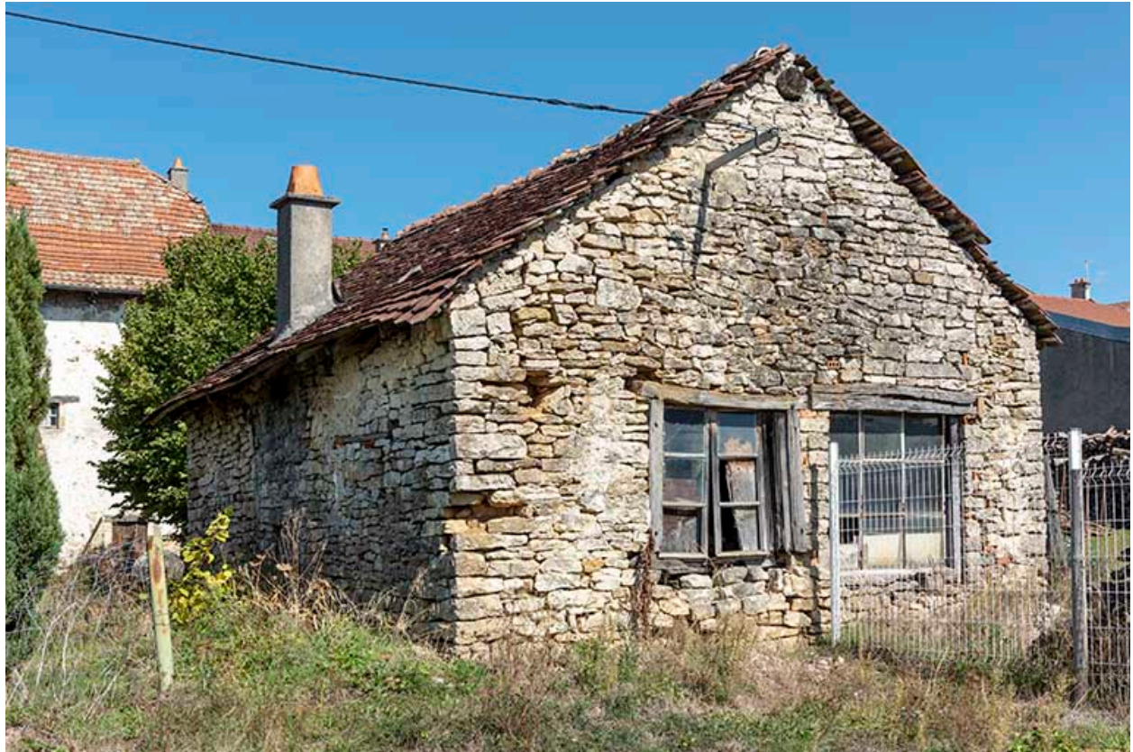
Forge : façade postérieure, de trois quarts gauche.
