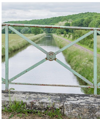
Détail du garde-corps.
