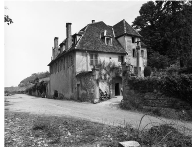
Vue générale depuis la rue. Phot. Yves Sancey IVR43_19813900202X
