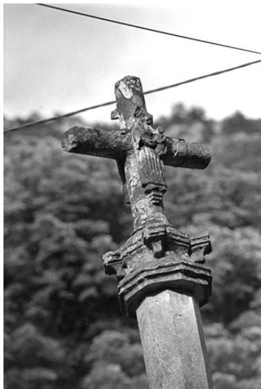
Croix monumentale : détail de la partie supérieure. Phot. Yves Sancey IVR43_19743900571Z
