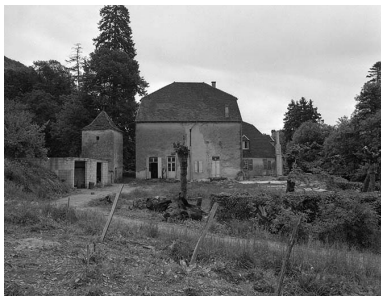
Façade nord. Phot. Yves Sancey IVR43_19813900203X
