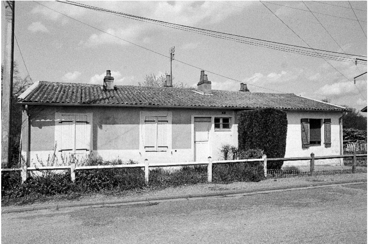
Bâtiment à 3 logements " type R ", 1939-1945.
