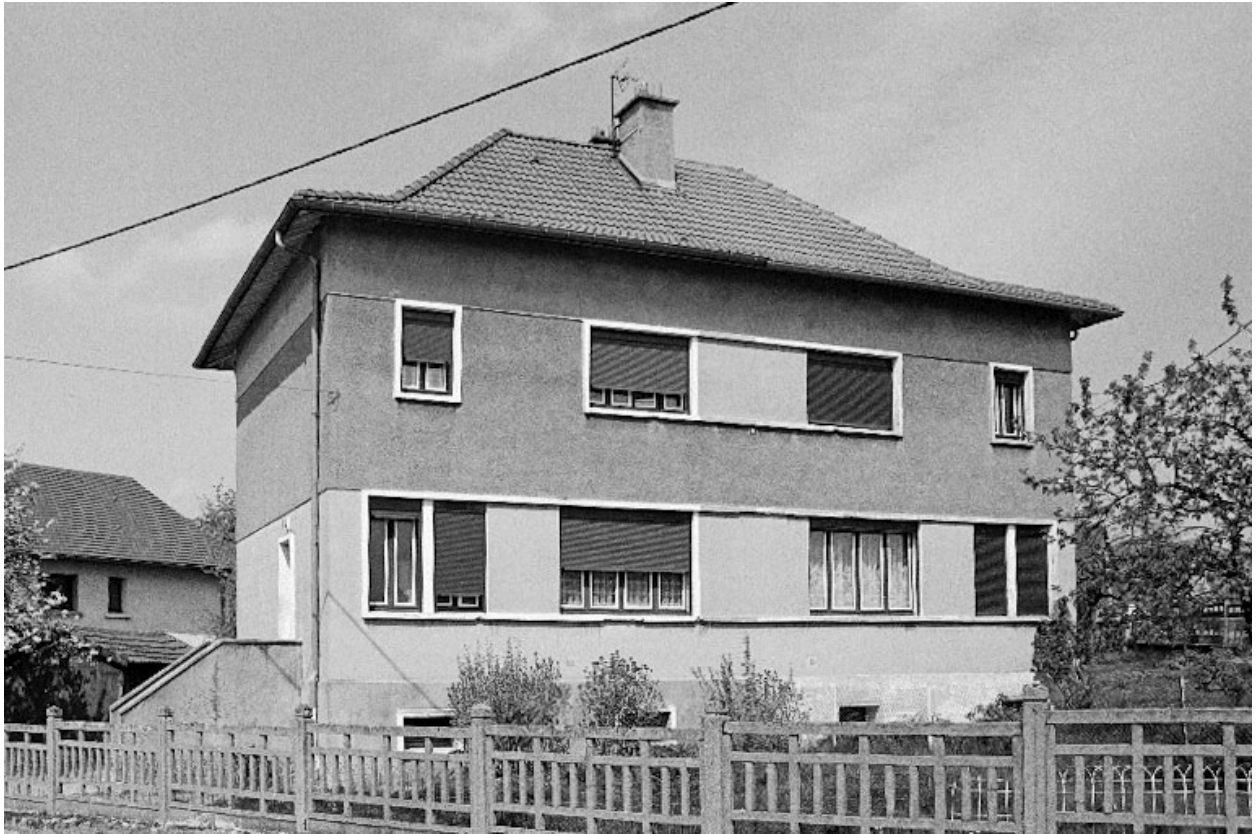
Bâtiment à 2 logements " type 16 rectifié ", toit à longs pans et croupes, 1946-1948.
