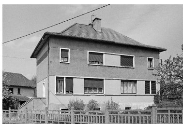
Bâtiment à 2 logements " type 16 rectifié ", toit à longs pans et croupes, 1946-1948. Phot. Frédéric Pillet IVR26_19987100200Z
