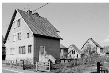
Bâtiment à 2 logements " type 16 " à meneaux, 1946-1948. Phot. Frédéric Pillet IVR26_19987100199Z
