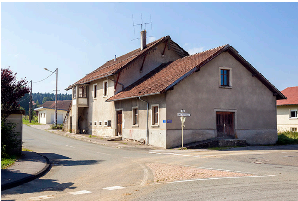
Façades postérieure et latérale droite.
