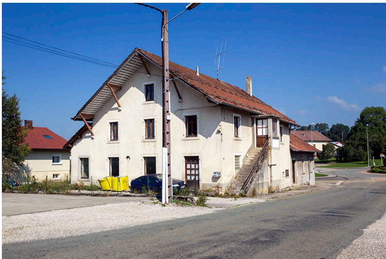
Façades antérieure et latérale droite.
