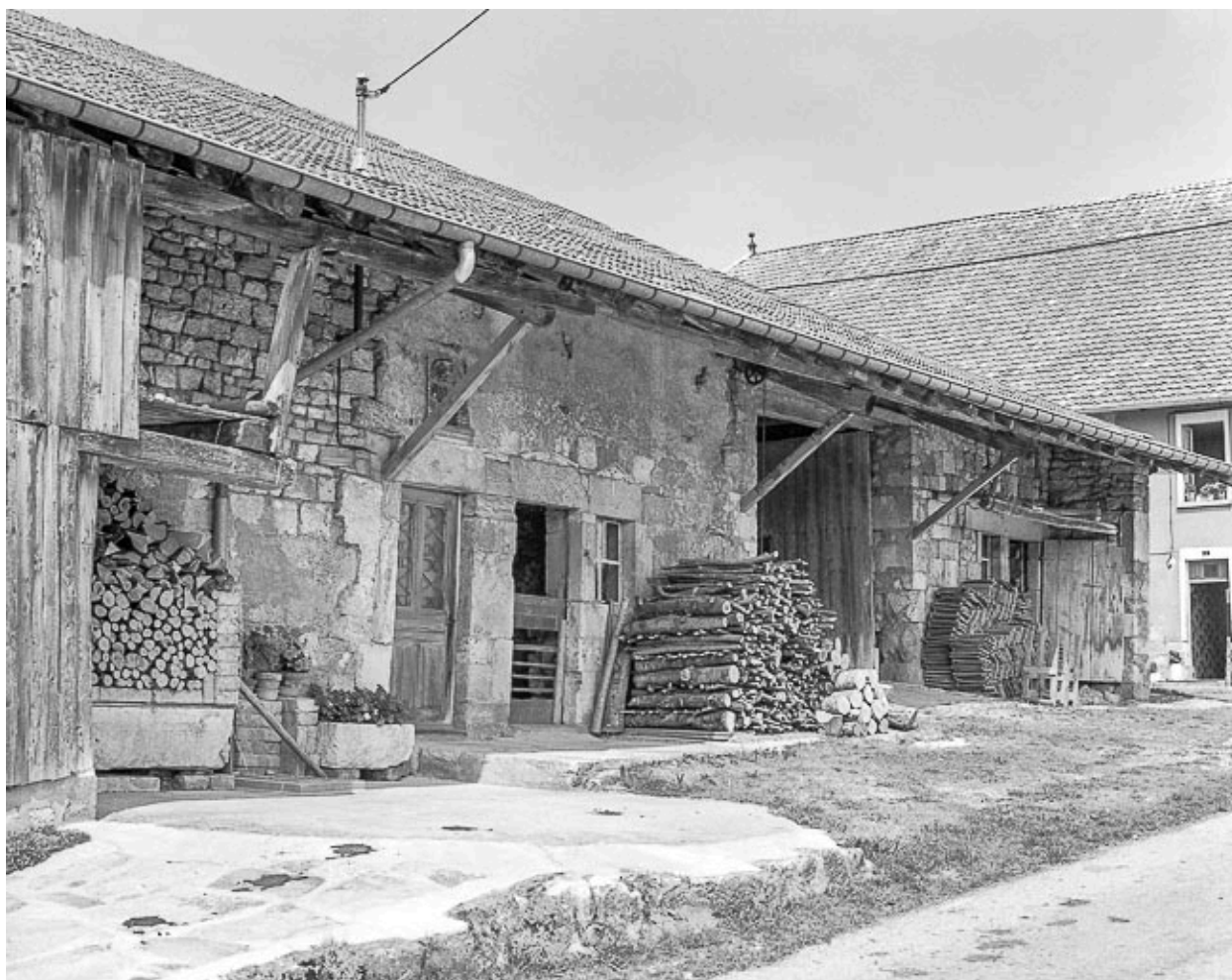
Ferme : goutterot sur rue.
