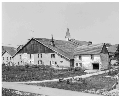
Ferme vue de trois quarts. Phot. Dominique Dominguez IVR43_19792500844X
