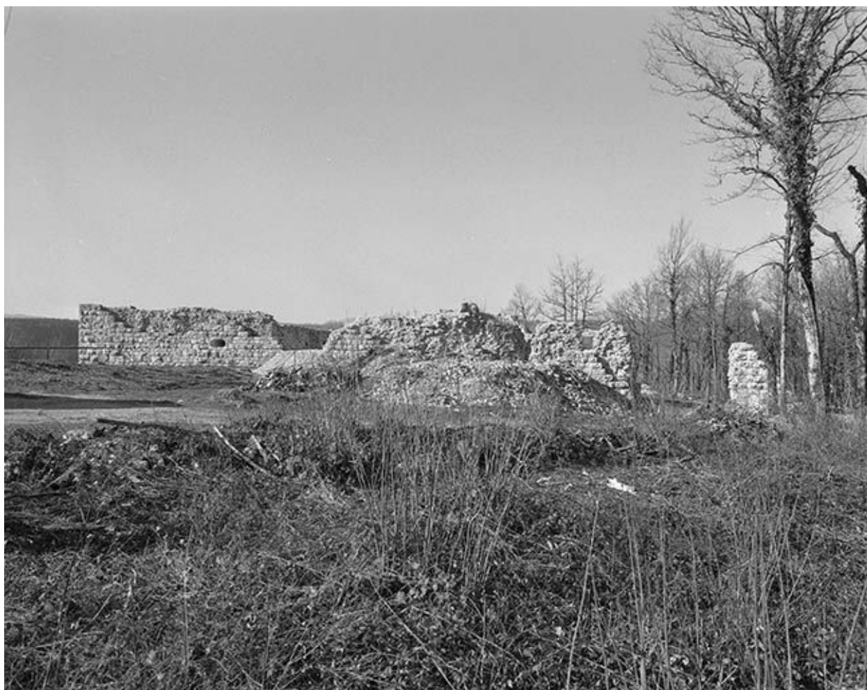
Vue générale du mur d'enceinte depuis l'est.
