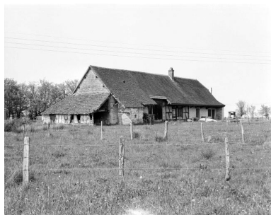
Vue générale. Phot. Bernard Lardière IVR43_19793900319X
