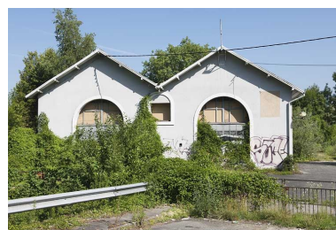
Pignons de la salle des turbines.
