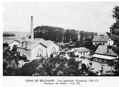
Usine de Belchamp. Vue d'ensemble.
