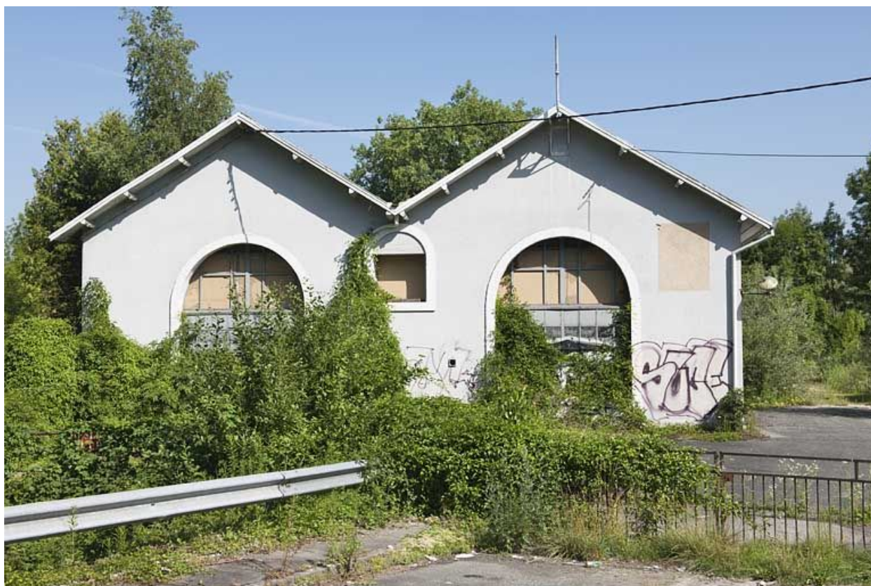
Pignons de la salle des turbines.
