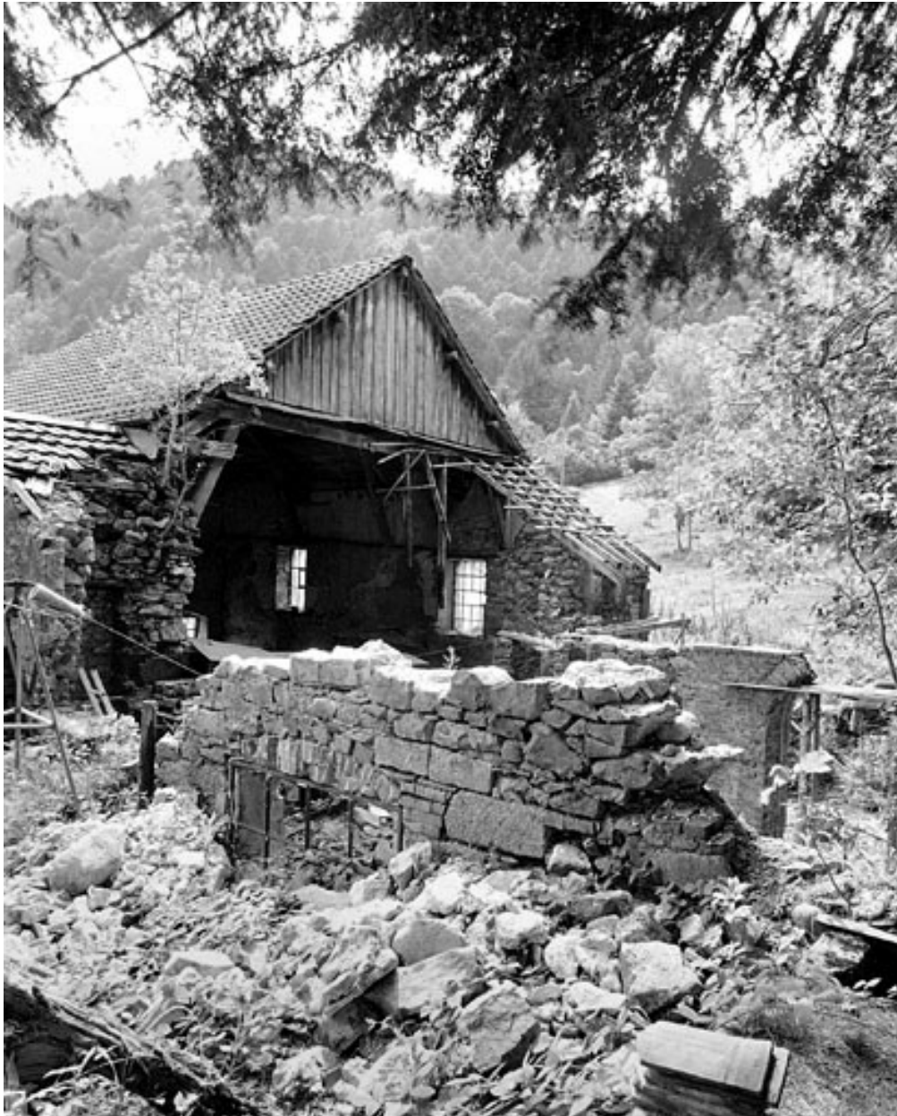
Vestiges de la salle des machines.
