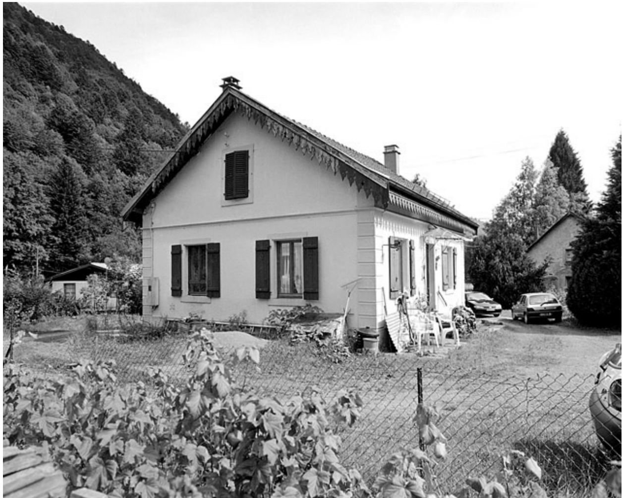
Logement de contremaître.
