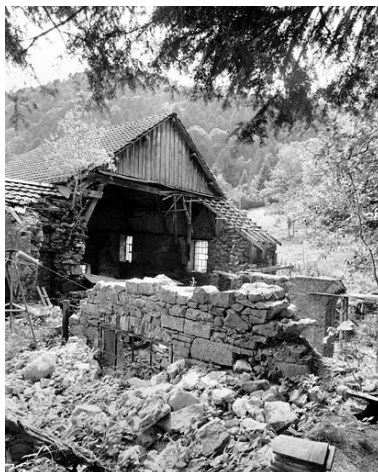
Vestiges de la salle des machines.
