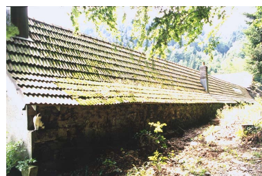
Versant nord (brisé) d'un shed. Phot. Yves Sancey IVR43_20009000101ZA
