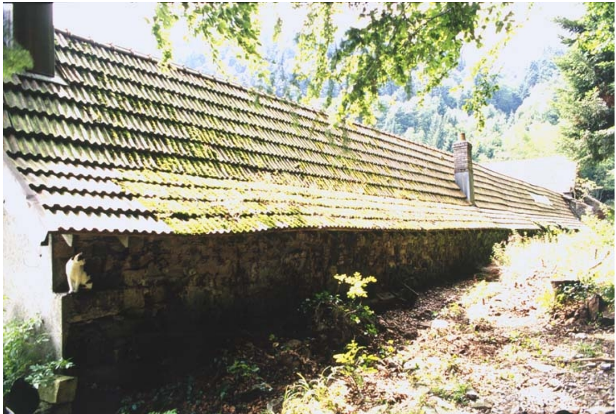
Versant nord (brisé) d'un shed.
