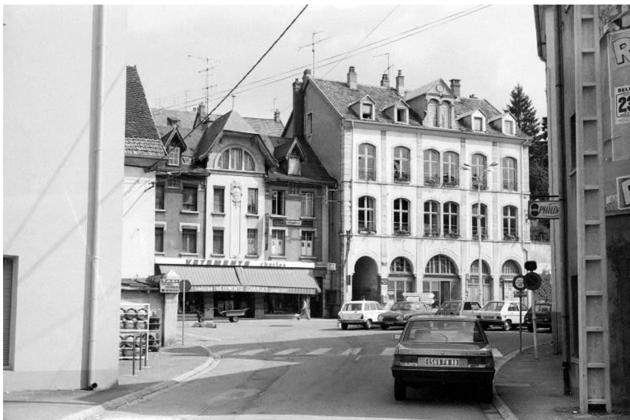
Ecole : façades antérieure et latérale droite.
