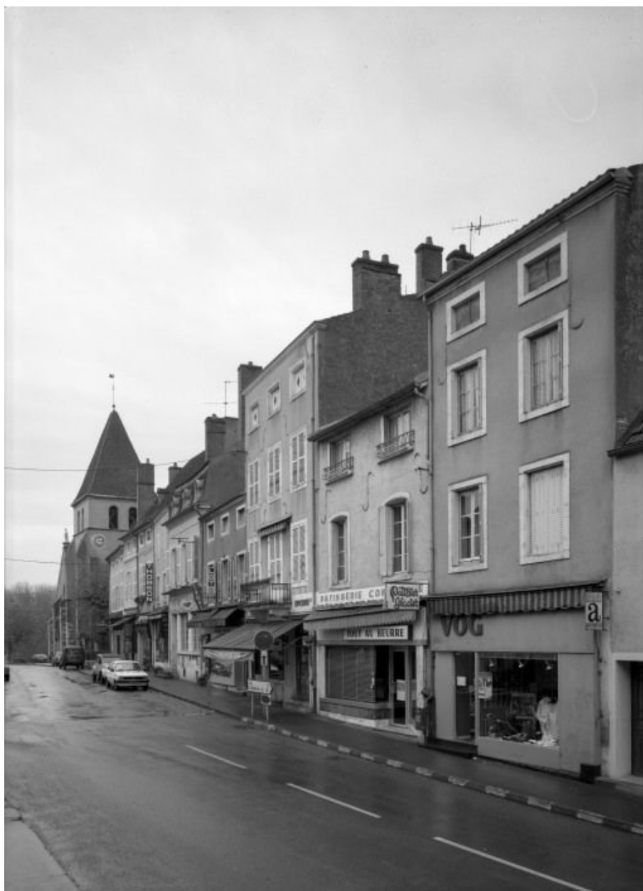
Alignement de 9 maisons (Cada. 1977, sect. AD, parc. 190 à 199 ; rue de La République).
