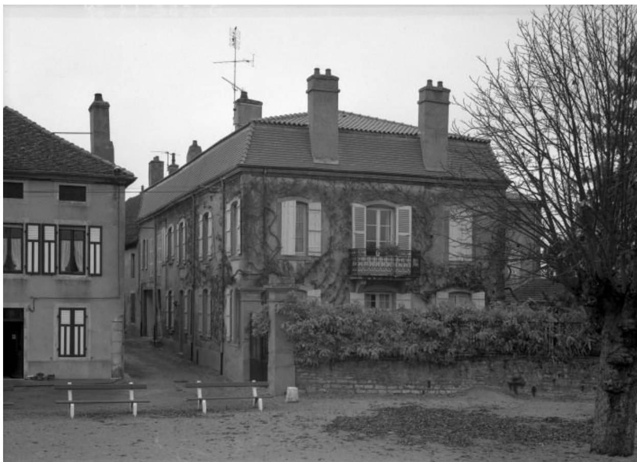
Vue d'ensemble d'une maison (cada. 1977, sect. AD, parc. 228 ; rue du Pignon ; rue du Bac, 9 ).
