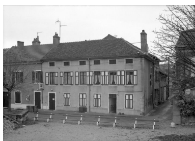
Vue d'ensemble d'une maison datée 1817 (cada. 1977, sect. AD, parc. 211 ; 11 rue du Pignon). Phot. Michel Rosso IVR26_19867100343V
