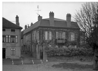
Vue d'ensemble d'une maison (cada. 1977, sect. AD, parc. 228 ; rue du Pignon ; rue du Bac, 9). Phot. Michel Rosso IVR26_19867100342V
