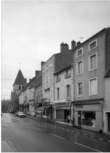
Alignement de 9 maisons (Cada. 1977, sect. AD, parc. 190 à 199 ; rue de La République). Phot. Michel Rosso IVR26_19867100345V
