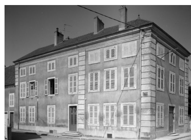
Vue d'ensemble d'une maison (cada. 1977, sect. AC, parc. 72 ; Rue Marguerite de Busseuil, 9 ; Quai du Doubs, 18). Phot. Michel Rosso IVR26_19867100386V
