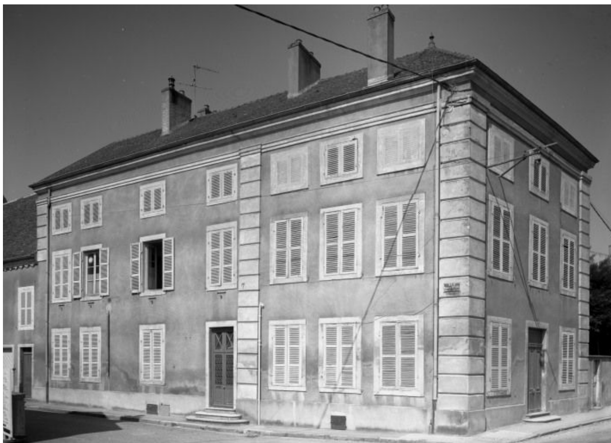
Vue d'ensemble d'une maison (cada. 1977, sect. AC, parc. 72 ; Rue Marguerite de Busseuil, 9 ; Quai du Doubs, 18).
