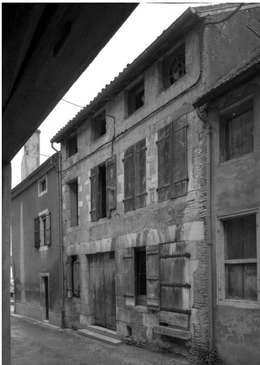
Vue d'ensemble d'une maison (cada. 1977, sect. AD, parc. 212).
