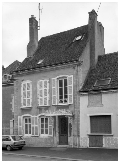
Façade d'une maison (cada. 1977, sect. AD, parc. 58 ; 22 rue de Beaune). Phot. Michel Rosso IVR26_19867100392V
