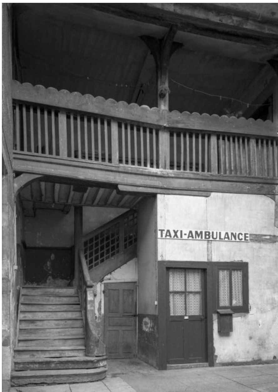
Maison au 1-3 rue Marguerite de Busseuil : corps droit de la maison abritant l'escalier et la galerie de l'étage (cada. 1977, sect. AC, parc. 60).
