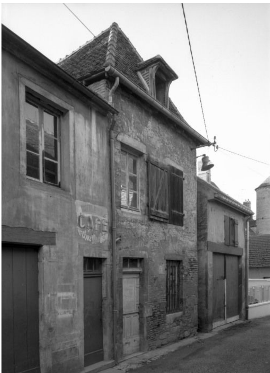
Maison située au 27 Grande rue (cada. 1977, sect. AC, parc. 51) : façade postérieure sur la rue du Portail.
