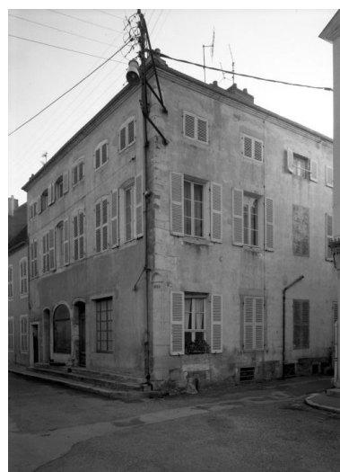
Vue d'ensemble d'une maison datée 1845 (cada. 1977, sect. AC, parc. 114 ; 2 rue François Fertault). Phot. Michel Rosso IVR26_19867100369V
