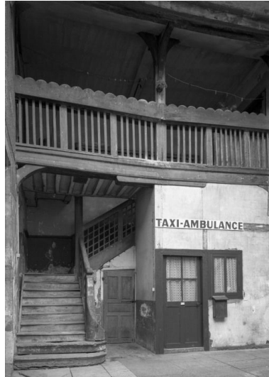
Maison au 1-3 rue Marguerite de Busseuil : corps droit de la maison abritant l'escalier et la galerie de l'étage (cada. 1977, sect. AC, parc. 60). Phot. Michel Rosso IVR26_19867100384V
