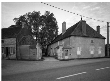
Vue d'ensemble d'une ferme située à La Maison Blanche (1977 AH 33). Phot. Michel Rosso IVR26_19867100272V
