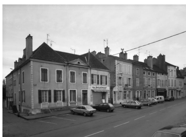
Alignement de maisons rue de la République. Phot. Michel Rosso IVR26_19867100349V
