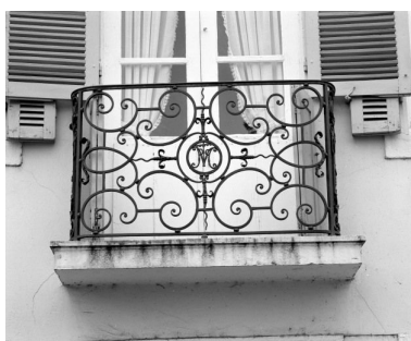
Maison située 2 place de la Liberté (cada. 1977, sect. AD, parc. 115) : grille du balconnet. Phot. Michel Rosso IVR26_19867100356X
