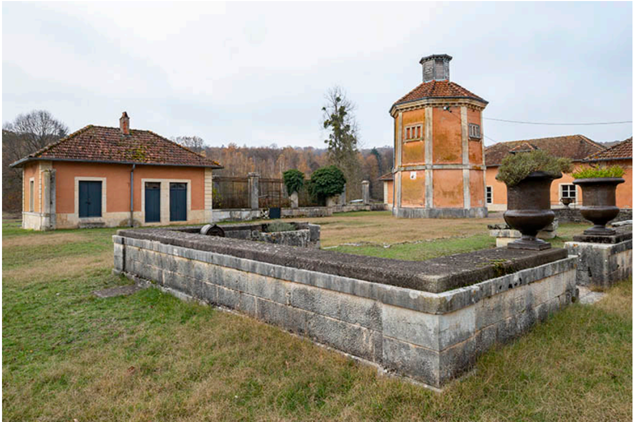
Dépendances et pigeonnier, vue d'ensemble depuis le sud-est.
