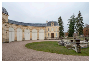
Élévation de l'aile droite et du pavillon de droite sur la cour. Phot. Jérôme Mongreville IVR43_20187000770NUC4A
