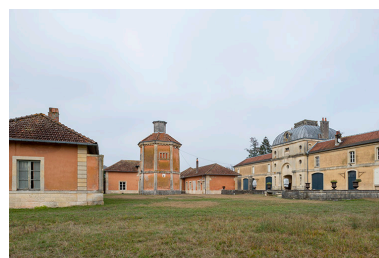
Dépendances et pigeonnier, vue d'ensemble depuis le sud-ouest. Phot. Jérôme Mongreville IVR43_20187000799NUC4A
