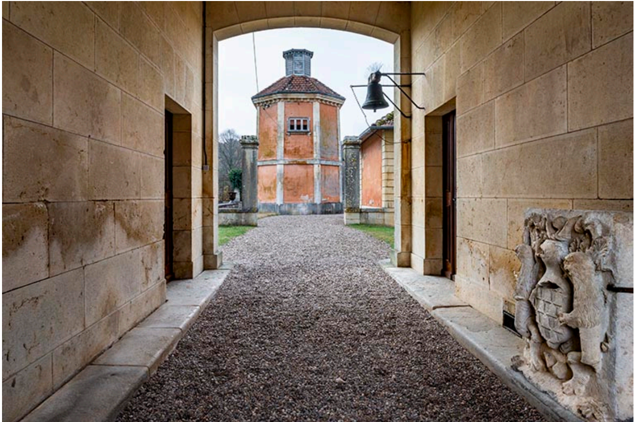
Passage de la cour de l'écurie vers le pigeonnier.
