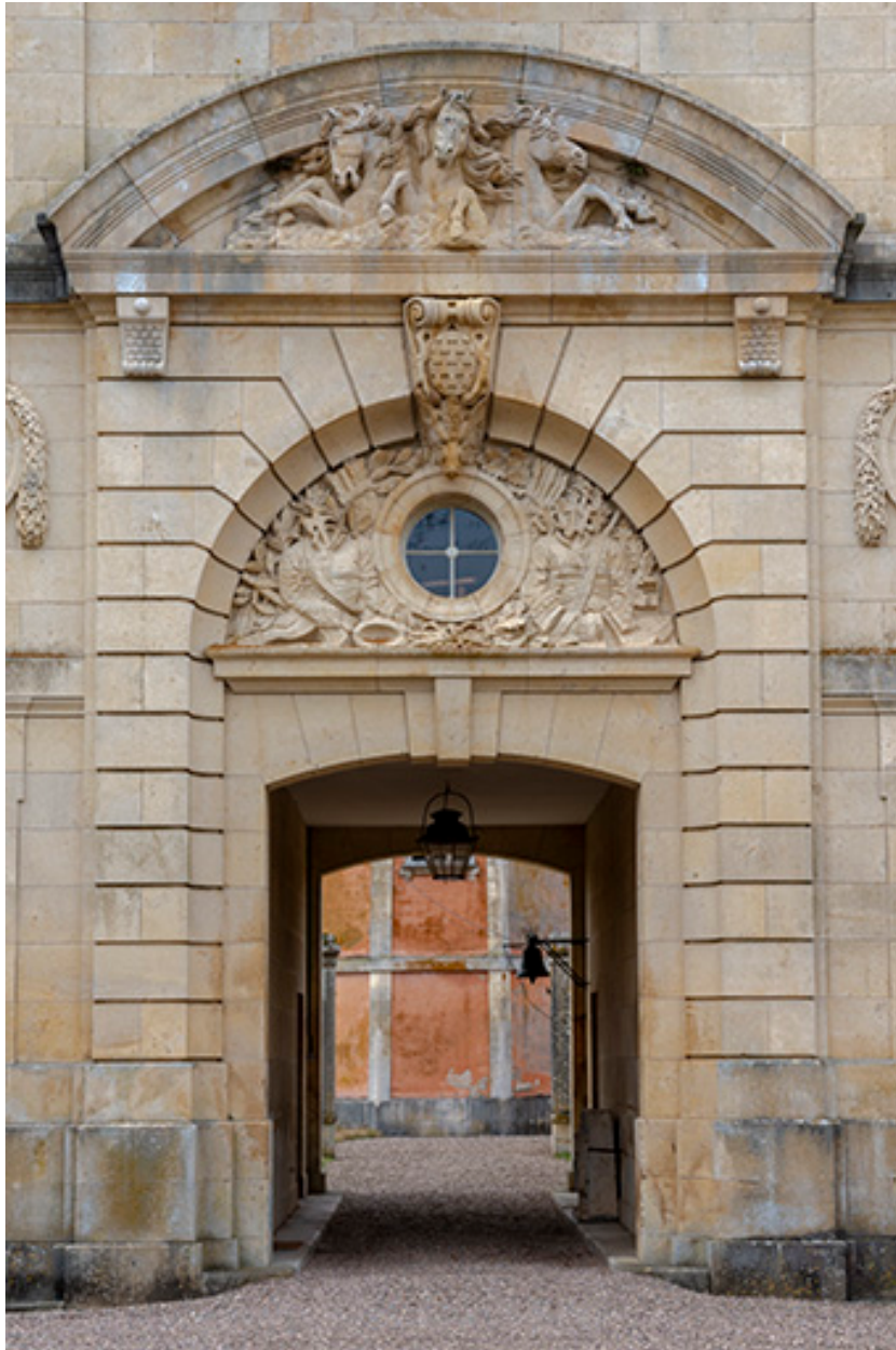
Portail à porte cochère du pavillon central.
