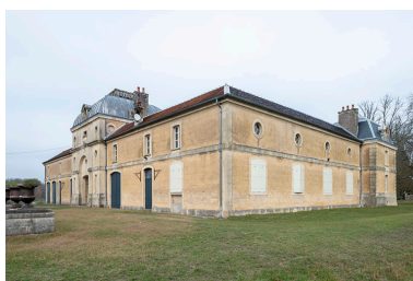
Façade ouest et façade sud de l'écurie. Phot. Jérôme Mongreville IVR43_20187000794NUC4A
