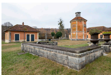
Dépendances et pigeonnier, vue d'ensemble depuis le sud-est. Phot. Jérôme Mongreville IVR43_20187000796NUC4A
