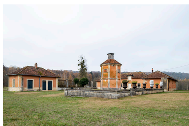
Dépendances et pigeonnier, vue d'ensemble depuis le sud-est. Phot. Jérôme Mongreville IVR43_20187000795NUC4A
