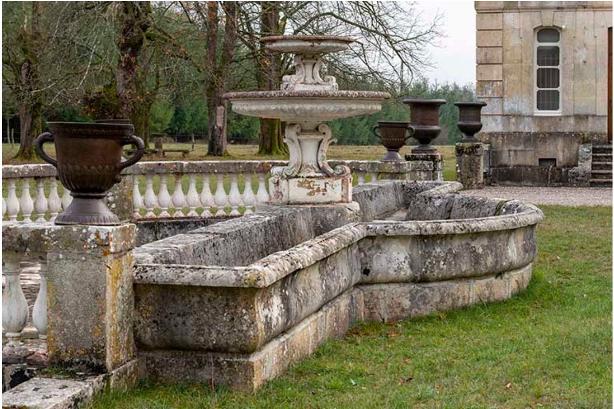
Fontaine et abreuvoir dans la cour de l'écurie, vue depuis le nord.
