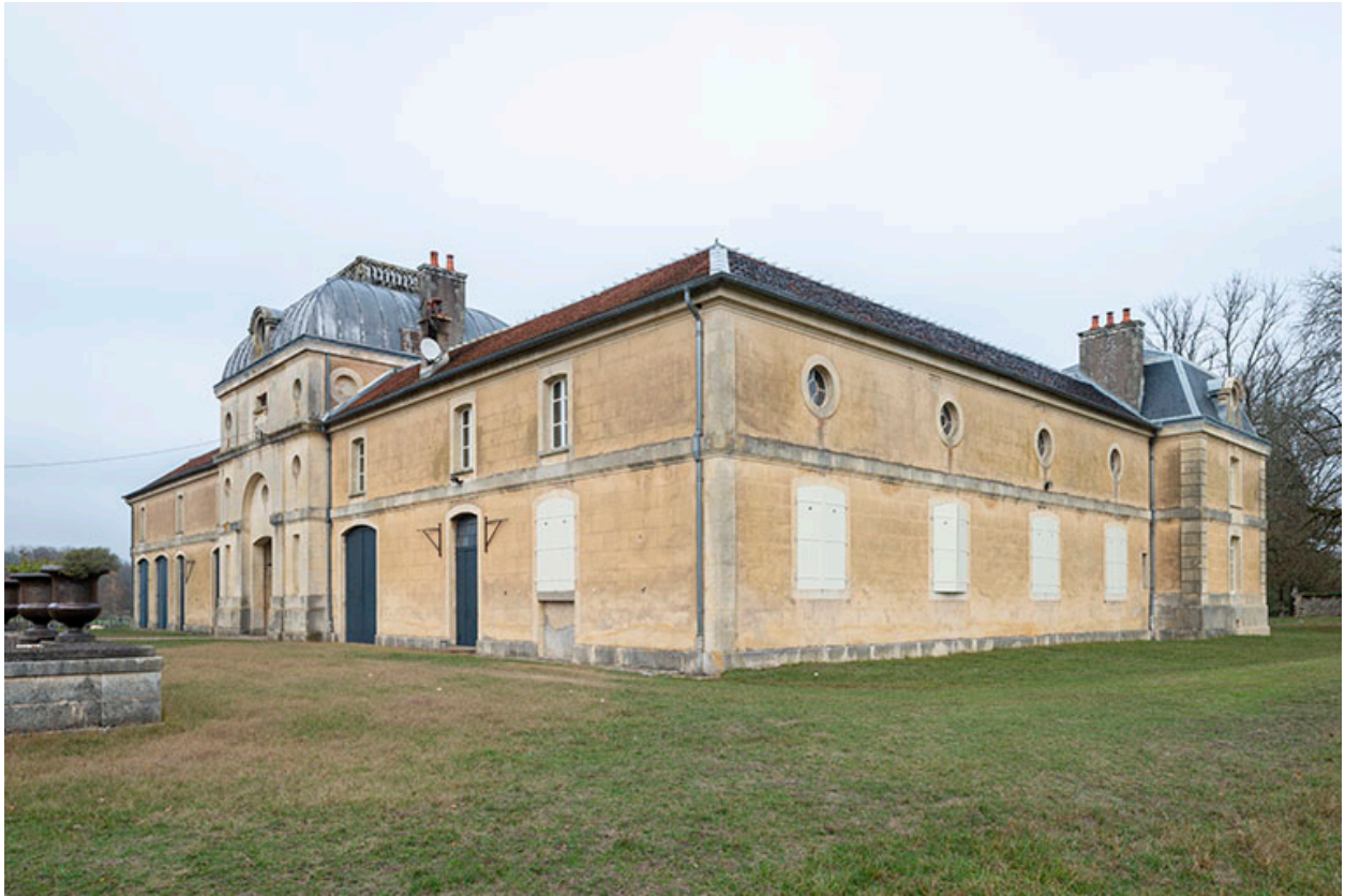
Façade ouest et façade sud de l'écurie.
