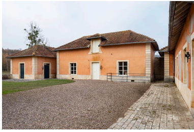
Bâtiments des dépendances du côté nord de la cour. Phot. Jérôme Mongreville IVR43_20187000792NUC4A
