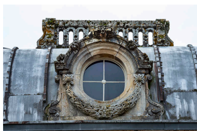
Lucarne percée d'un oculus et ornée de deux volutes, d'une guirlande et d'un félin. Phot. Jérôme Mongreville IVR43_20187000778NUC4A
