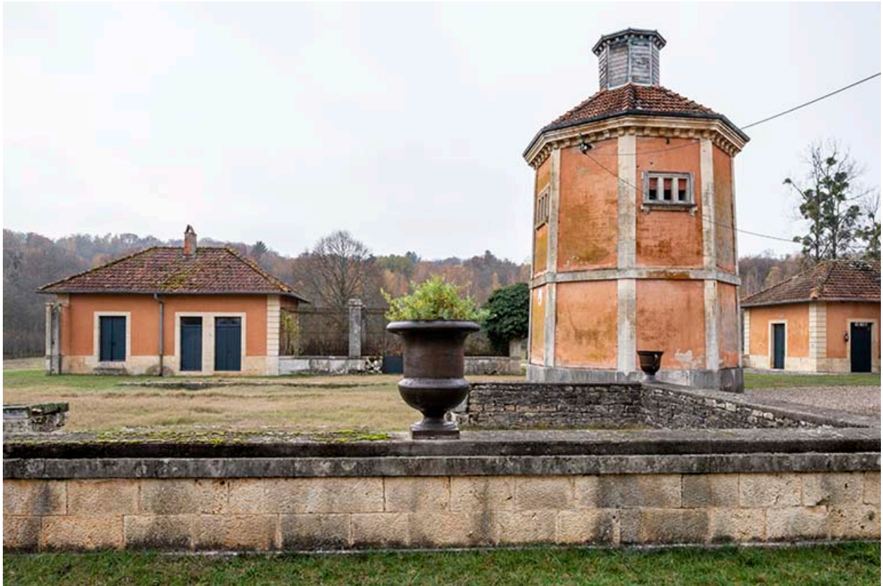
Pigeonnier, vue depuis l'est.
