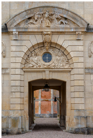
Portail à porte cochère du pavillon central. Phot. Jérôme Mongreville IVR43_20187000775NUC4A
