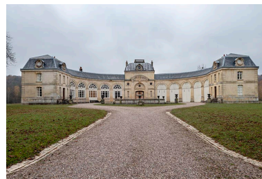
Façade orientale de l'écurie. Phot. Jérôme Mongreville IVR43_20187000768NUC4A
