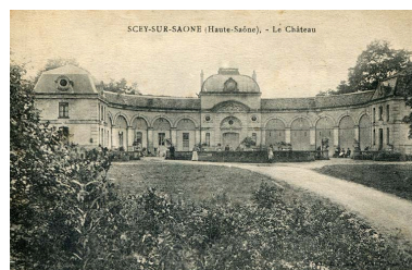
Façade orientale de l'écurie, vue ancienne, après l'obturation des arcades. IVR43_20197000227NUC4A
