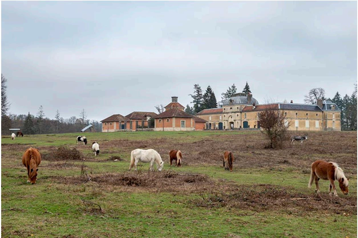
Vue d'ensemble depuis le parc, vers le nord-est.
