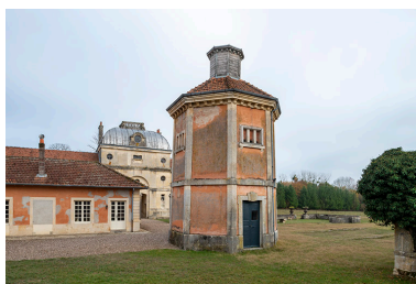
Pigeonnier, vue depuis le nord-ouest. Phot. Jérôme Mongreville IVR43_20187000798NUC4A
