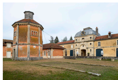
Pigeonnier, vue depuis le sud-ouest. Phot. Jérôme Mongreville IVR43_20187000797NUC4A
