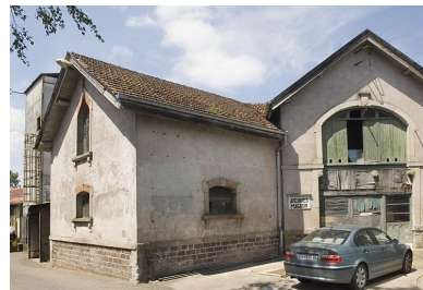
Aile ouest de l'atelier de saboterie (?). Phot. Jérôme Mongreville IVR43_20097000461NUC2A
