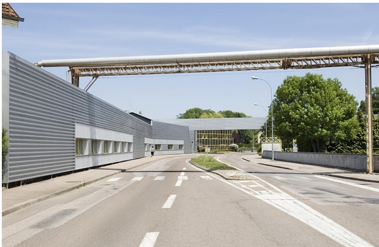
Vue de l'usine depuis l'avenue Jacques Parisot.
