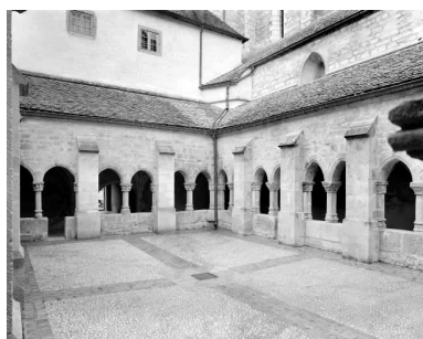
Cour intérieure. Phot. Yves Sancey IVR43_19782500257V
