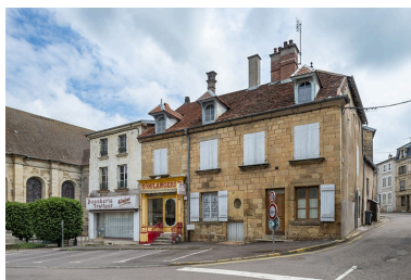
La maison dans son contexte, de trois quarts droite. Phot. Jérôme Mongreville IVR43_20217000210NUC4A
