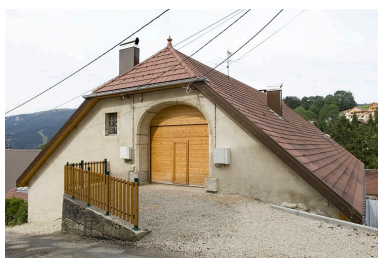
Façade latérale gauche et pont de l'ancienne grange, rue du Châtelet. Phot. Jérôme Mongreville IVR43_20092501154NUC2A
