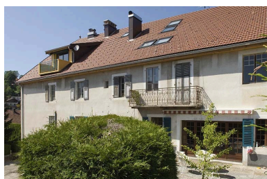
Façade postérieure. Phot. Jérôme Mongreville IVR43_20092501153NUC2A
