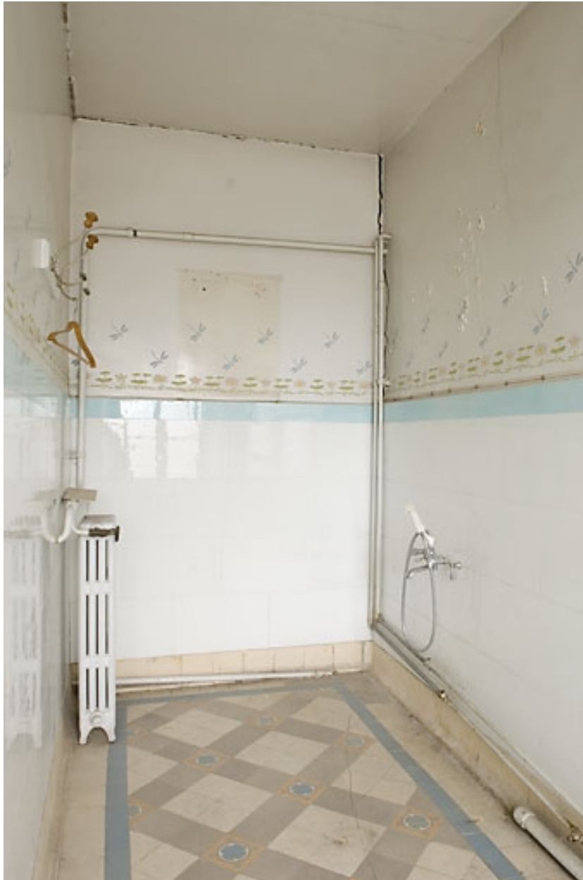
Ancienne salle de bains, dont la baie ouvre sur la rue des Remparts.
