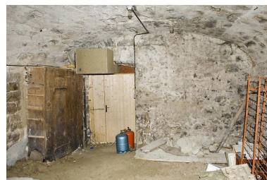
Cave voûtée. Phot. Jérôme Mongreville IVR43_20082500809NUC2A
