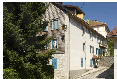
Façade latérale droite et façade postérieure. Phot. Jérôme Mongreville IVR43_20092501152NUC2A
