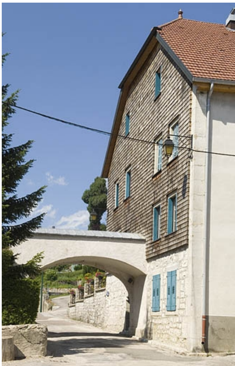
Façade latérale droite, côté rue de l'Eglise.
