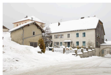
Vue rapprochée. Phot. Jérôme Mongreville IVR43_20092500032NUC2A
