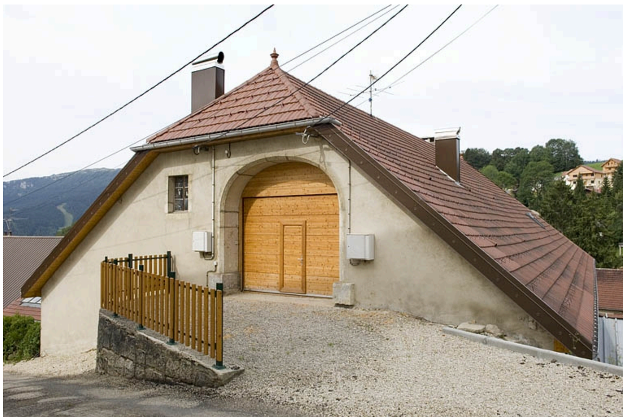
Façade latérale gauche et pont de l'ancienne grange, rue du Châtelet.
