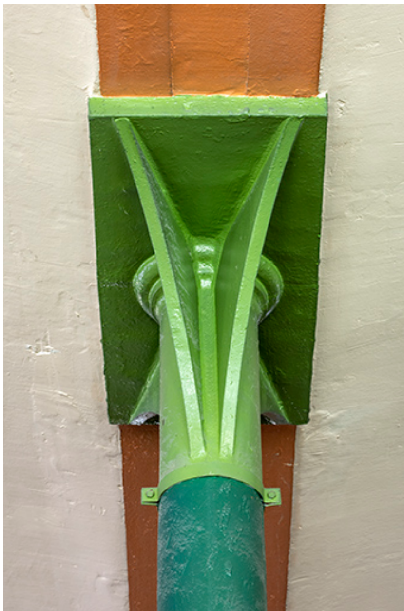
Atelier de fabrication (ancienne pointerie) : chapiteau d'un poteau en fonte.
