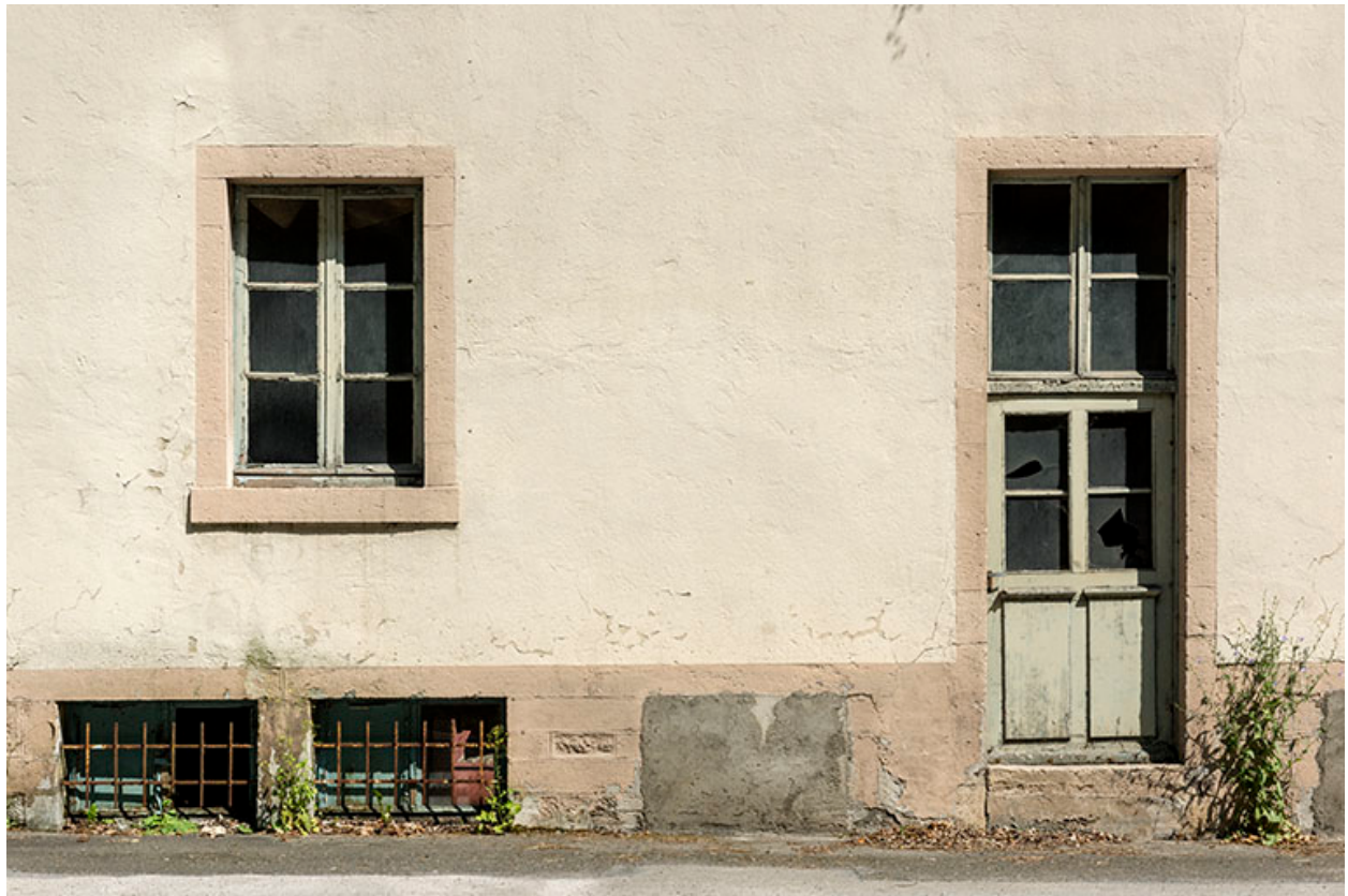
Bureau, façade antérieure : détail.
