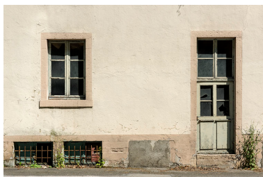
Bureau, façade antérieure : détail.
