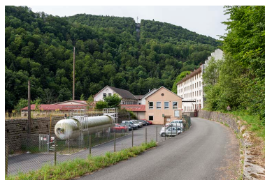
Vue d'ensemble, depuis l'entrée au nord. Phot. Sonia Dourlot IVR43_20192501500NUC4A
