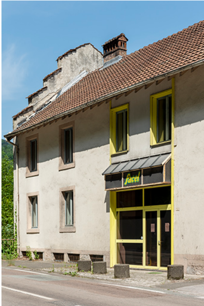
Bureau, façade antérieure : entrée.
