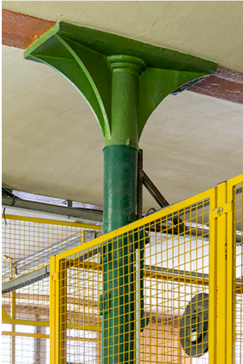
Atelier de fabrication (ancienne pointerie) : poteau en fonte (chapiteau).
