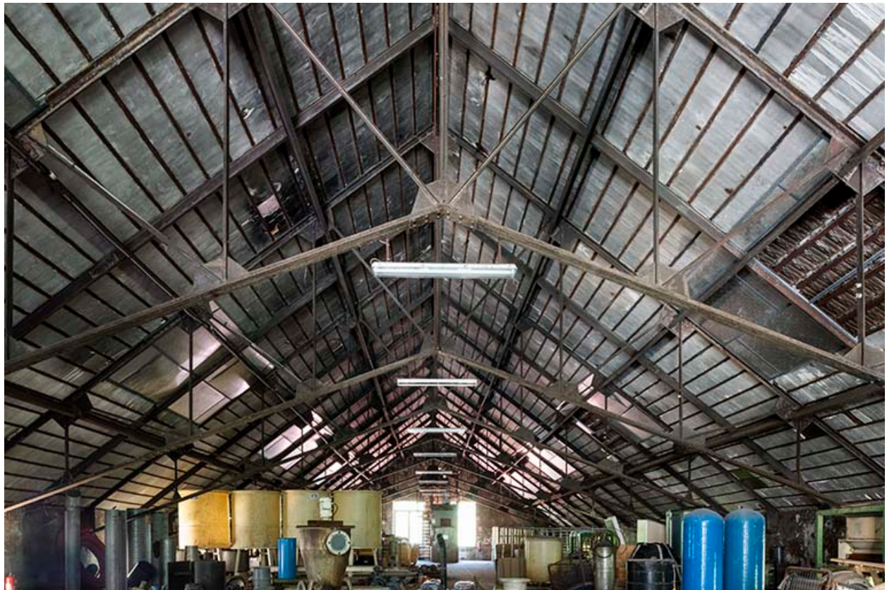
Atelier de fabrication (ancienne tréfilerie) : charpente métallique.
