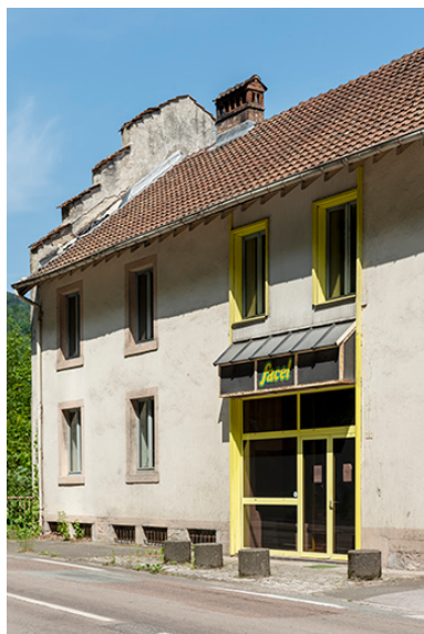
Bureau, façade antérieure : entrée.
