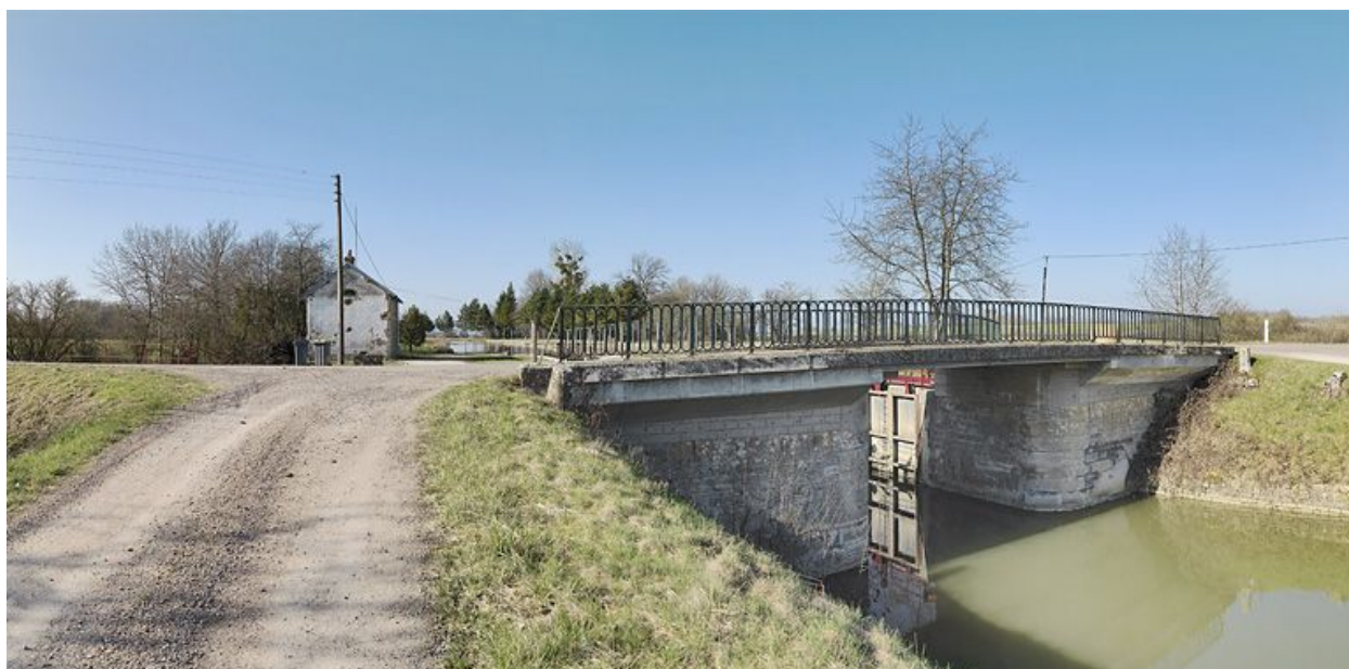
Le pont vu d'aval.
