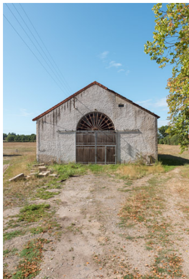
Vue de face (vue rapprochée). Phot. Pierre-Marie Barbe-Richaud IVR26_20195800605NUC4A
