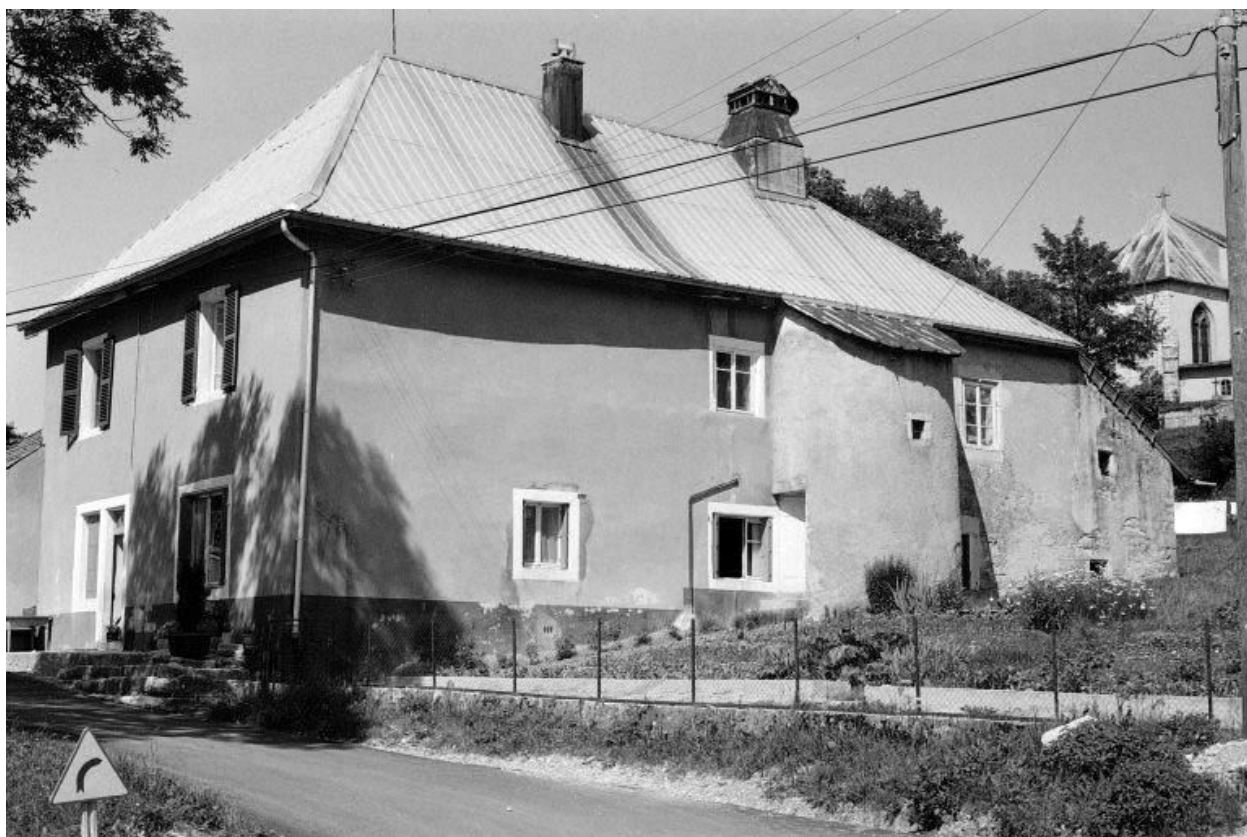
Façades antérieure et latérale droite.
