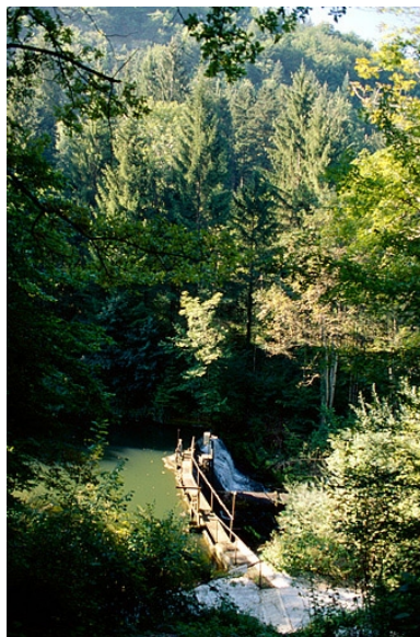
Barrage sur le bief de Balerne et départ de la conduite forcée.
