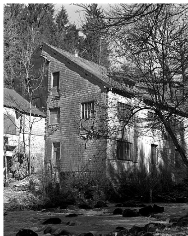
Ancien atelier de fabrication depuis le sud. Phot. Yves Sancey IVR43_19983900036X
