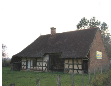
Vue d'ensemble de la façade.
