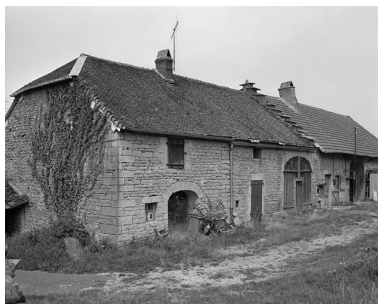
Ferme située rue du Château d'Eau. Phot. Yves Sancey IVR43_19843900165X
