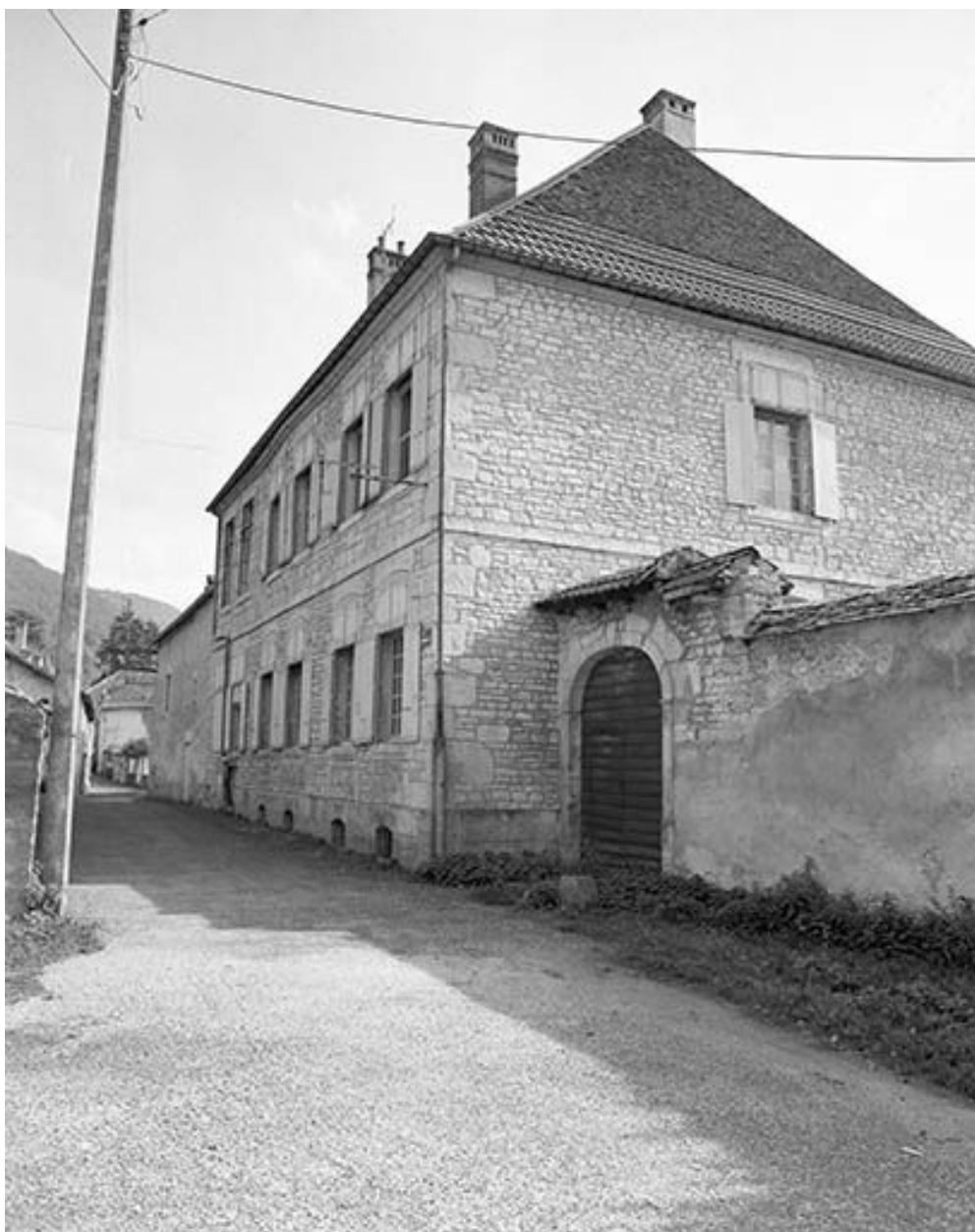
Façade sur la rue Saint-Antoine.
