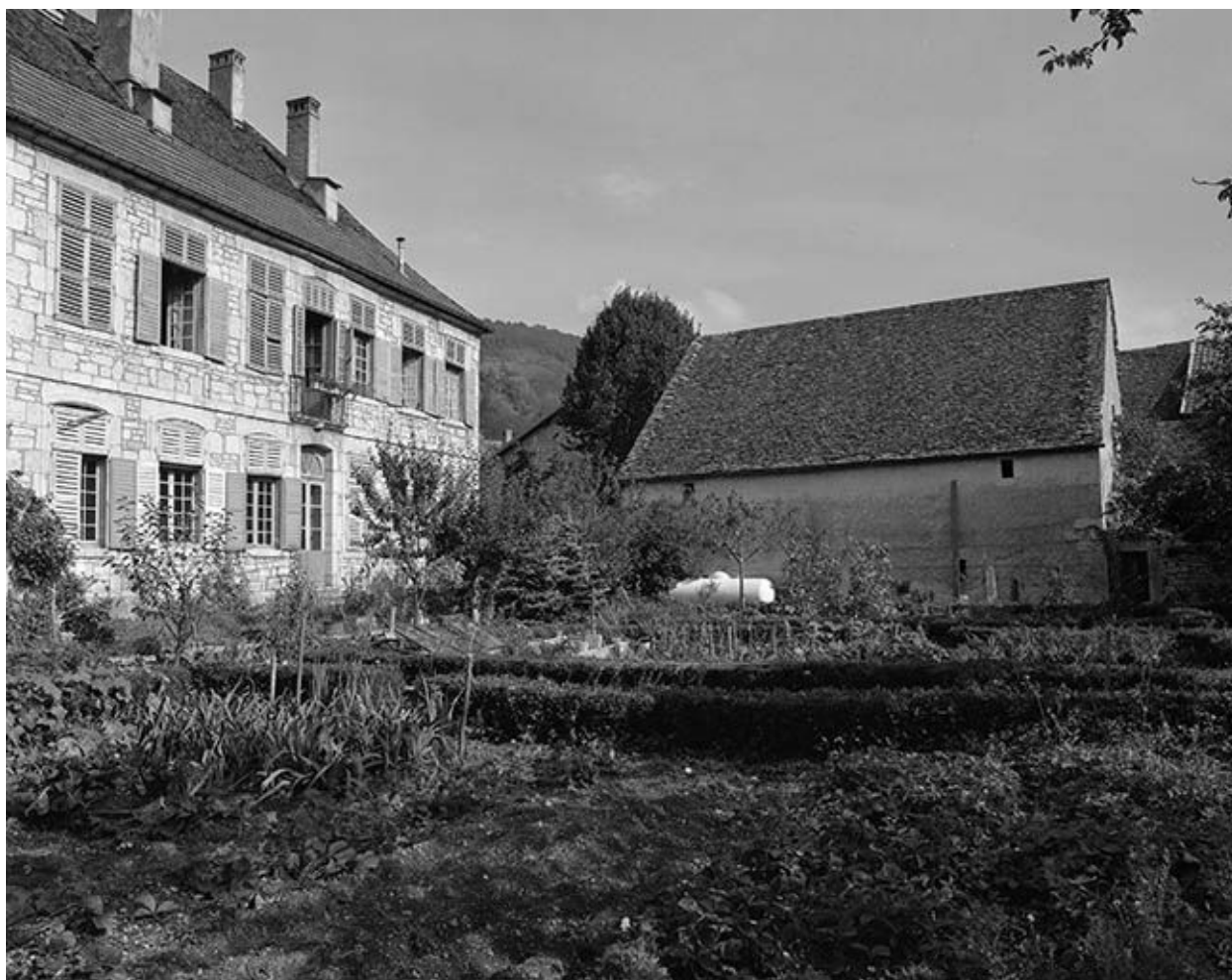
Vue d'ensemble depuis le jardin.
