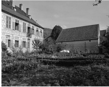
Vue d'ensemble depuis le jardin. Phot. Yves Sancey IVR43_19802501381X
