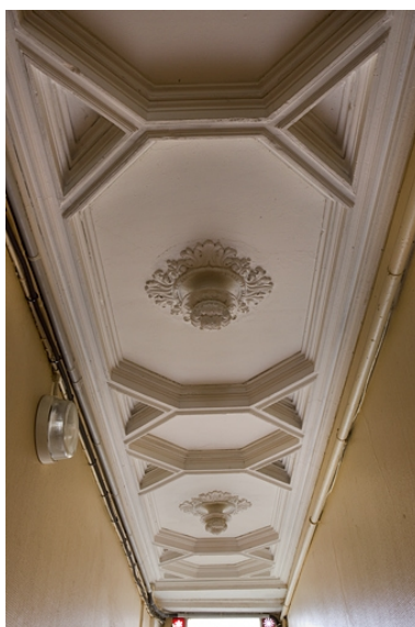
Logis principal : détail du plafond du couloir d'entrée. Phot. Yves Sancey IVR43_20102500933NUC2A
