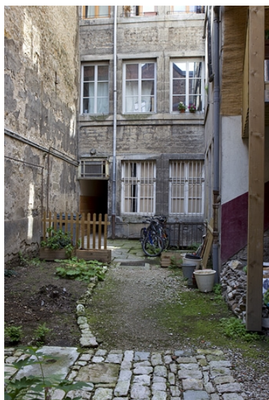
Logis principal, façade sur cour : détail du rez-de- chaussée et du premier étage. Phot. Yves Sancey IVR43_20102500935NUC2A
