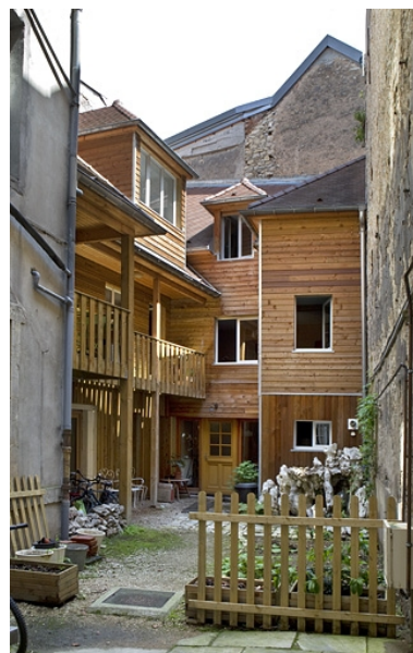
Logis secondaire : vue d'ensemble. Phot. Yves Sancey IVR43_20102500937NUC2A
