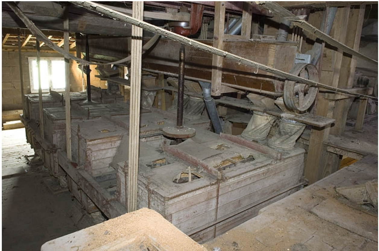
Vue plongeante sur les plansichters (3e étage).
