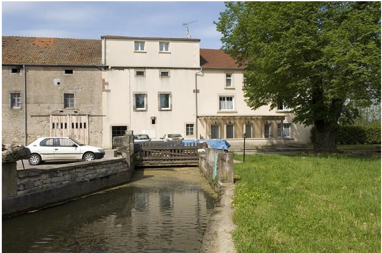
Bief d'amenée et façade antérieure.
