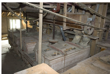
Vue plongeante sur les plansichters (3e étage). Phot. Jérôme Mongreville IVR43_20067000340NUCA
