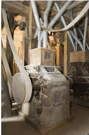
Convertisseur Teisset- Rose-Braut (1er étage). Phot. Jérôme Mongreville IVR43_20067000331NUCA
