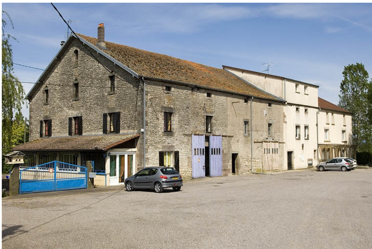
Vue d'ensemble depuis l'ouest.
