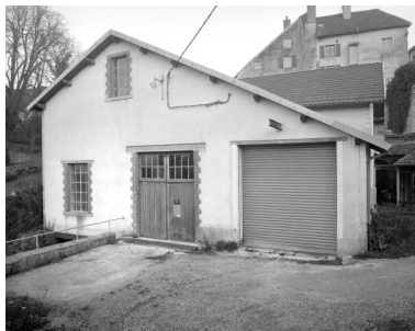
Façade antérieure depuis le sud-ouest. Phot. Jérôme Mongreville IVR43_19963901929X
