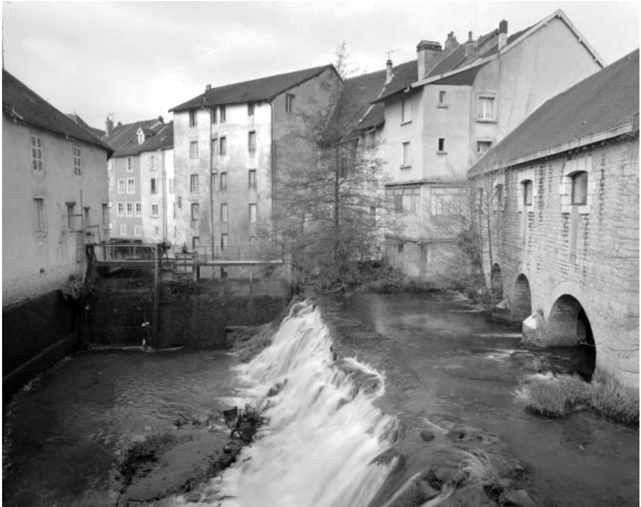
Le bassin de retenue vidé.
