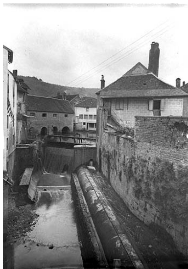
Bassin de retenue et conduite forcée depuis le pont. Phot. , Autr. Jules Manias IVR43_19963900381X
