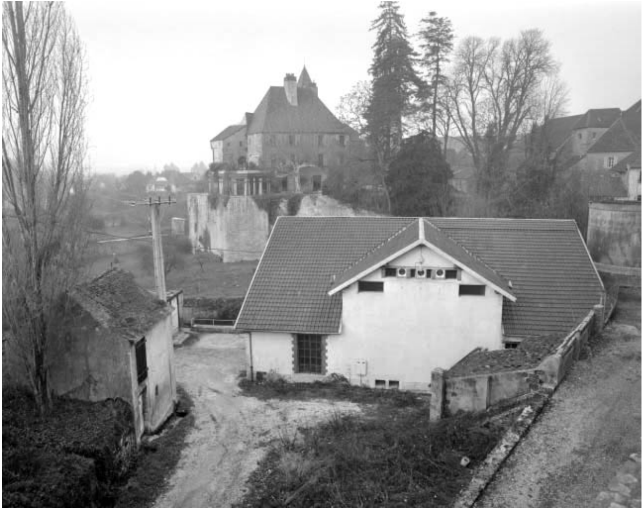
Vue plongeante sur la centrale.
