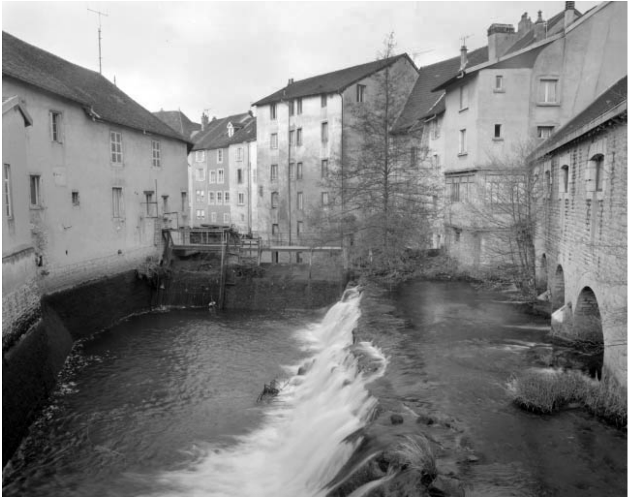
Remplissage du bassin de retenue.
