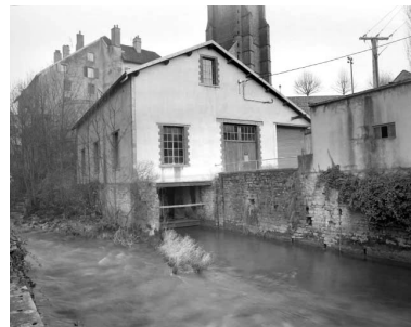
La salle des machines et la remise depuis la rive droite. Phot. Jérôme Mongreville IVR43_19963901931X
