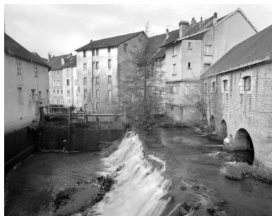
Le bassin de retenue vidé. Phot. Jérôme Mongreville IVR43_19973900525X
