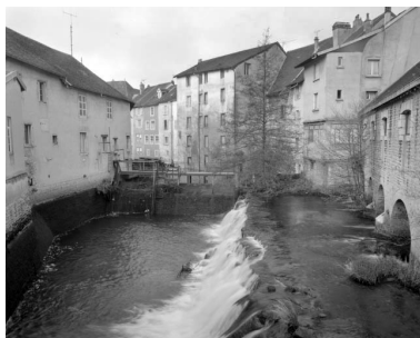
Remplissage du bassin de retenue. Phot. Jérôme Mongreville IVR43_19973900524X
