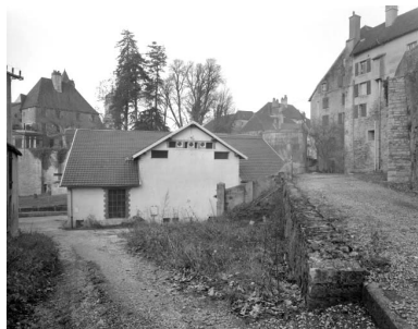
La centrale vue depuis l'entrée. Phot. Jérôme Mongreville IVR43_19963901932X
