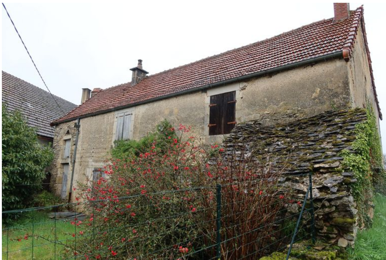
Vue de la ferme depuis la rue.
