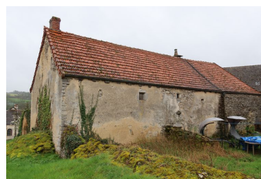
Vue du mur gouttereau
