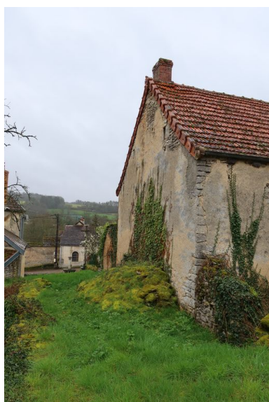
Vue de l'ancien four à pain, partiellement démoli et enfoui contre le mur pignon est.
